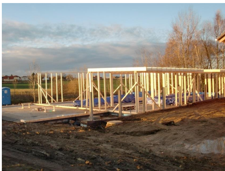
Obr. 4 – Sloupková konstrukce z fošen
