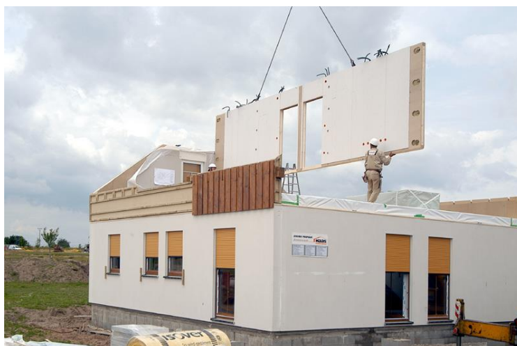
Obr. 3 – Montovaný systém ze sendvičových panelů
