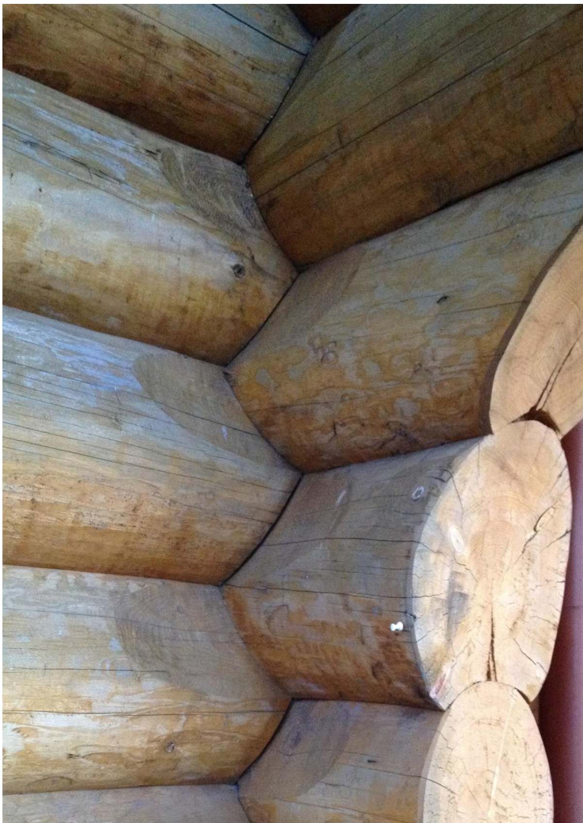
Obr. VII – Detail spoje u rohu obvodové konstrukce
