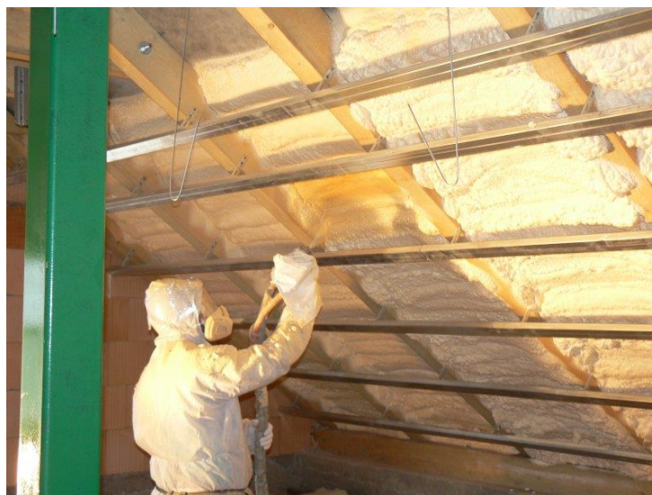
Obr. 10 – Stríkaná PUR pěna
