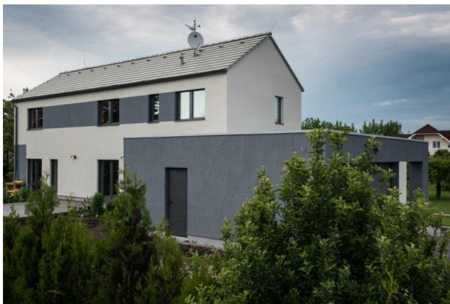
Obr. 21 – Pasivní dům, jižní strana
