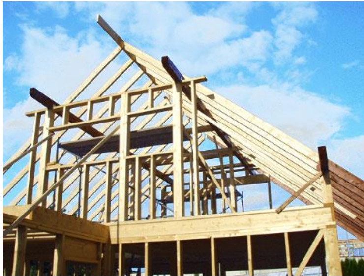
Obr. 2 – Skeletový systém dřevostavby
