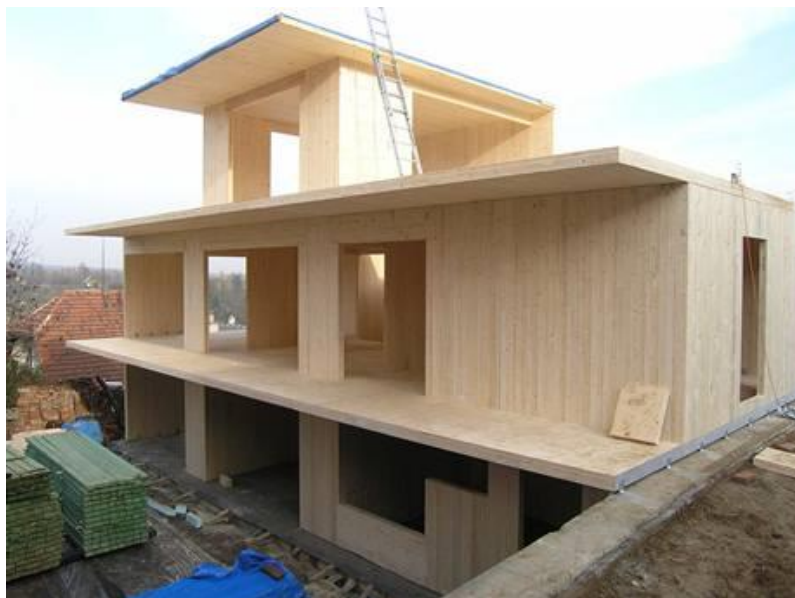
Obr. 5 – Panelová konstrukce z masivu
