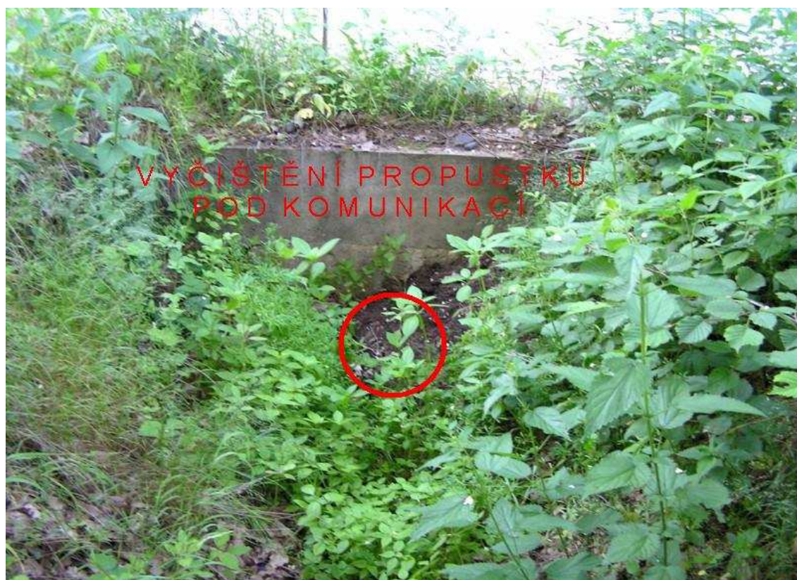
Zanesený a zarostlý propustek pod komunikací, stav k 1.4. 2010
