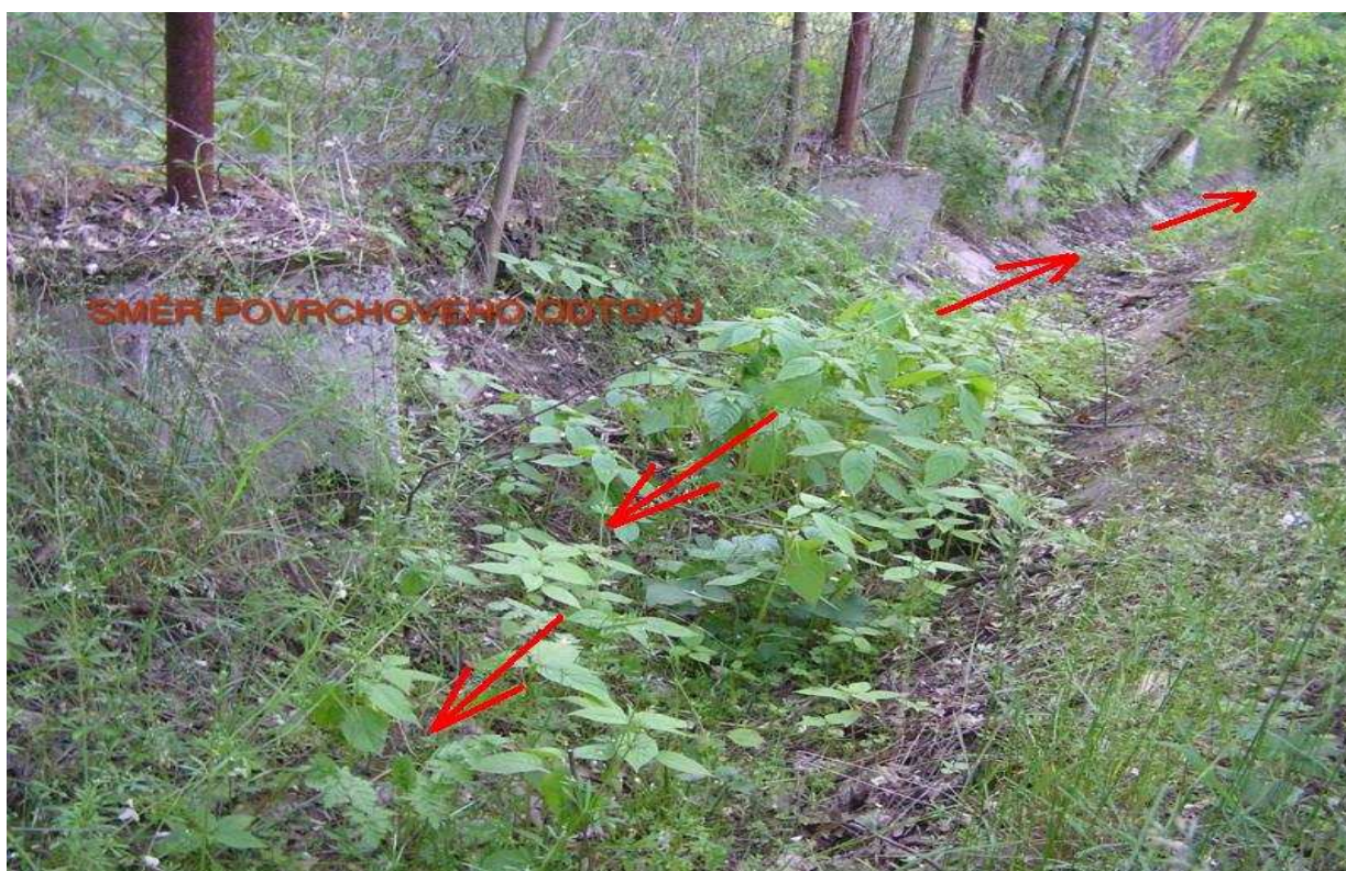
Zanesený a zarostlý propustek pod komunikací, stav k 1.4. 2010
