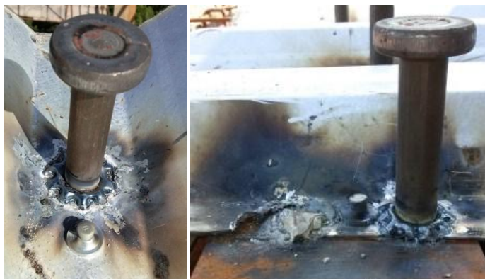
Obr. D.9 Přivaření trnu v případě předcházejícího uchycení pomocí nastřelovacích hřebů, zdroj: [39]
