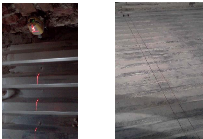
Obr. D.12 Označení polohy osy profilů pro přivaření trnů, zdroj: [39]
