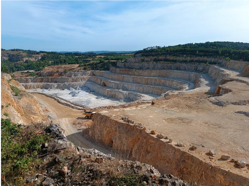
Obr. č. 2: Fotografie části velkolomu Čertovy schody (Zdroj: Kolouchová 2023).
