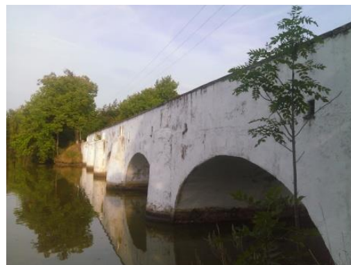
Obrázek 16 - Most s pilíři - detail
