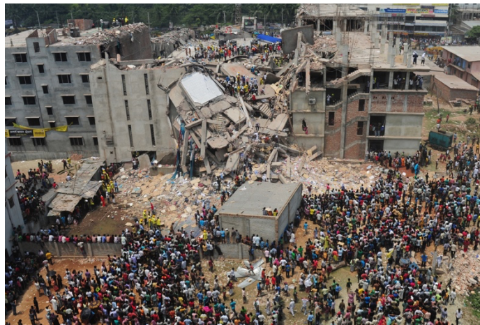
Obrázek 4 Zřícení budovy Rana Plaza; zdroj: The New York Times , 2023
