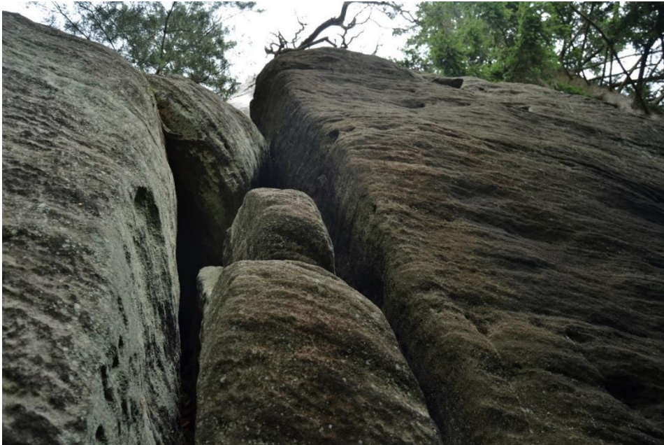
Obr. 25a: Jihozápadní stěna Zubaře.
