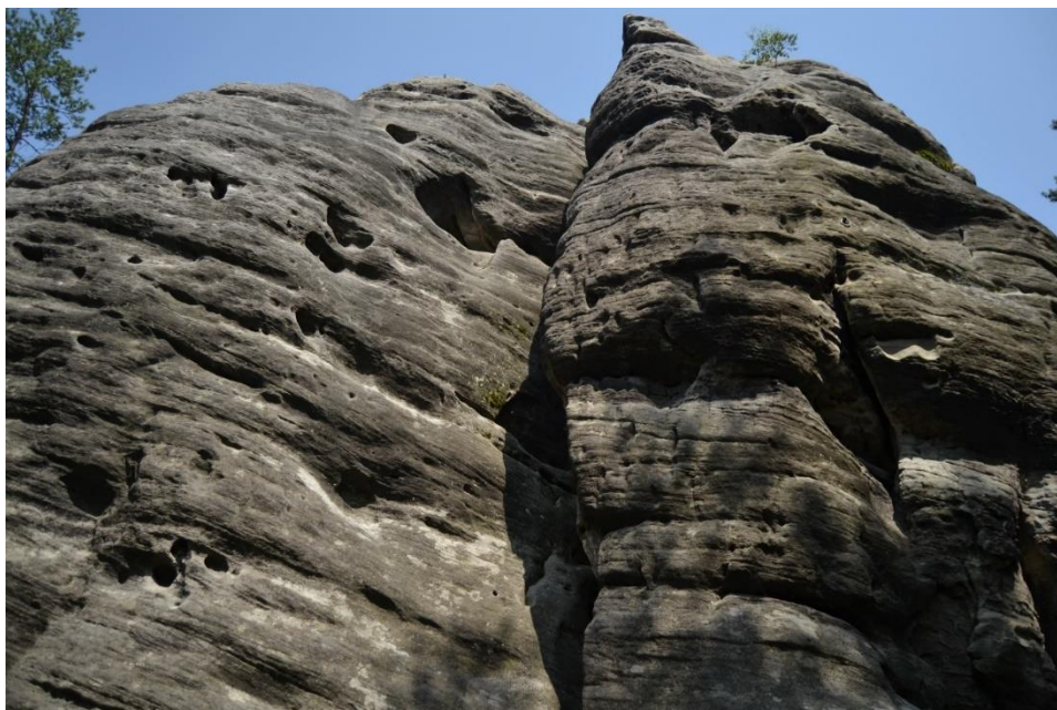
Obr. 15a: Jihozápadní stěna Mušketýra
