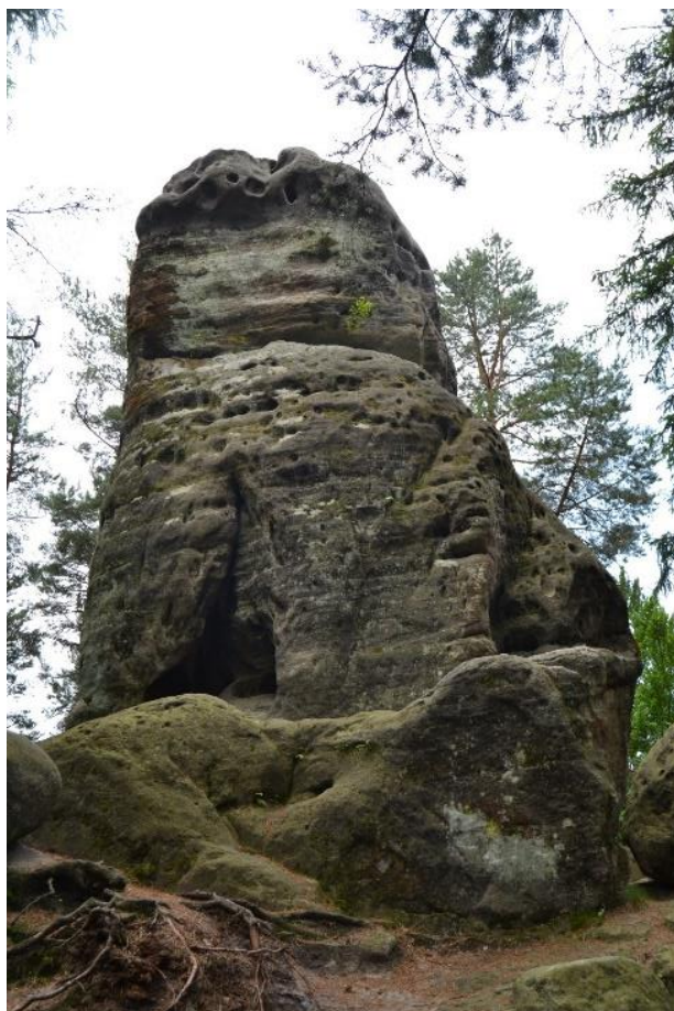
Obr. 9c: Severovýchodní stěna Hodináře
