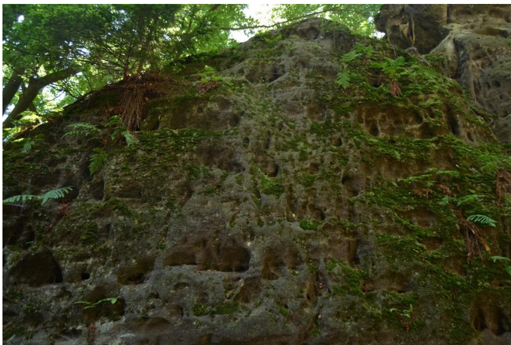
Obr. 41: Eroze mechového patra pod slaňovacím kruhem na Deštivé
