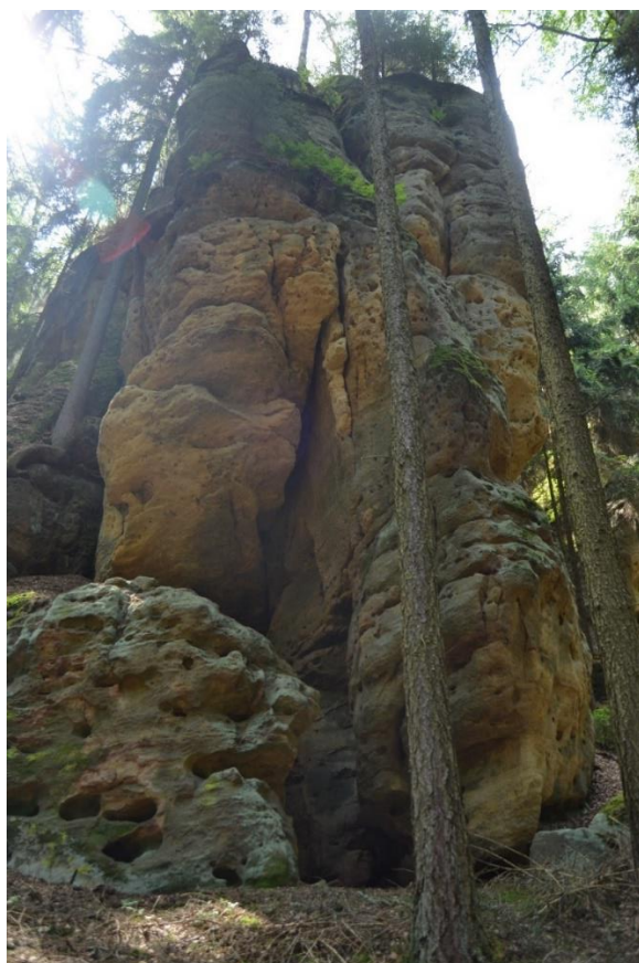
Obr. 29c: Severovýchodní stěna Lobkowiczké věže.
