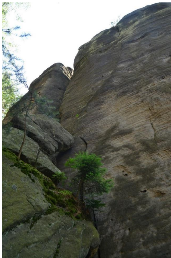
Obr. 22c: Severovýchodní stěna Kněže.
