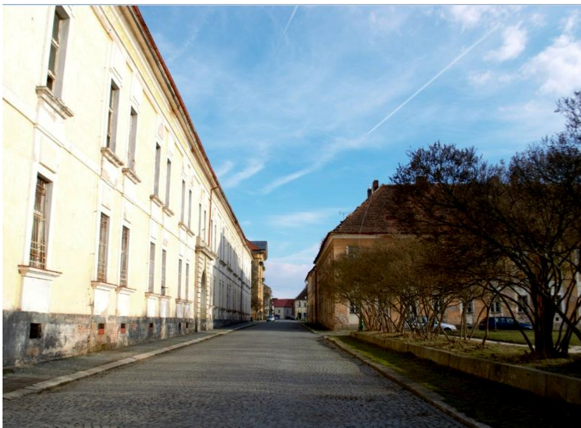
Obrázek 16 Bývalá vojenská nemocnice r. 2019
