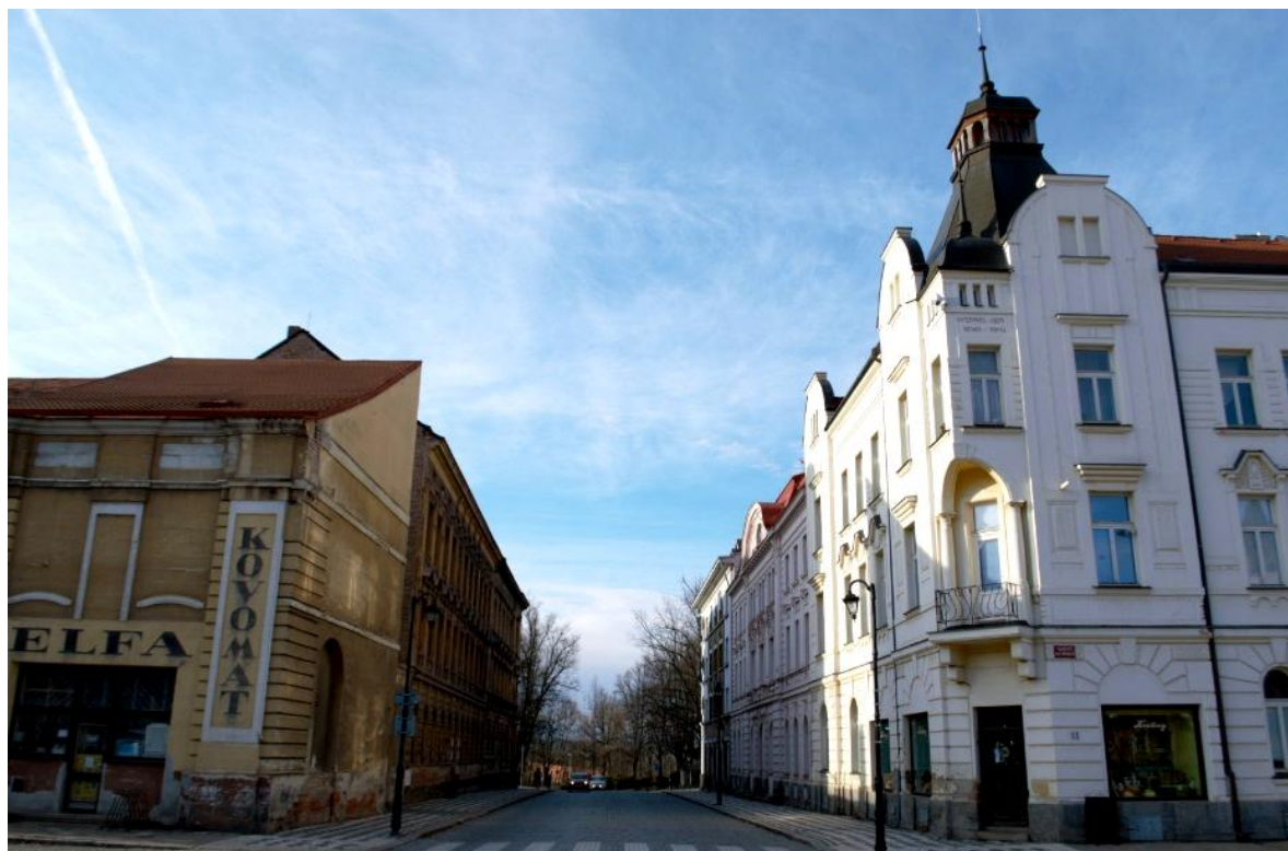
Obrázek 12 Bývalá hlavní stráž a Krupkova vila v r. 2019
