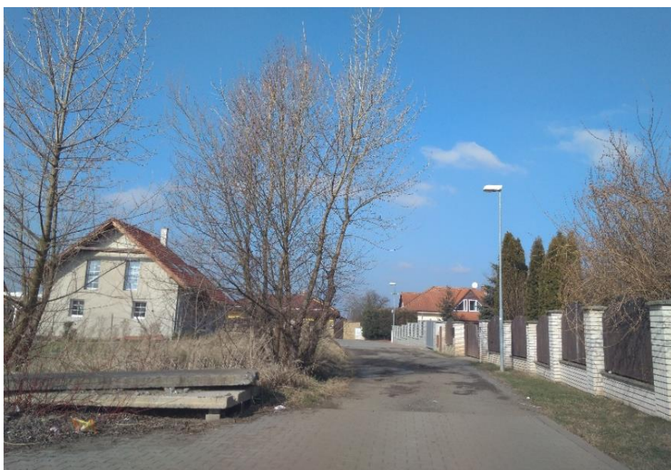
Obr. 34: Nedokončený úsek komunikace v předměstí Spořilov, březen 2018 (foto Vladimír Jíra)
