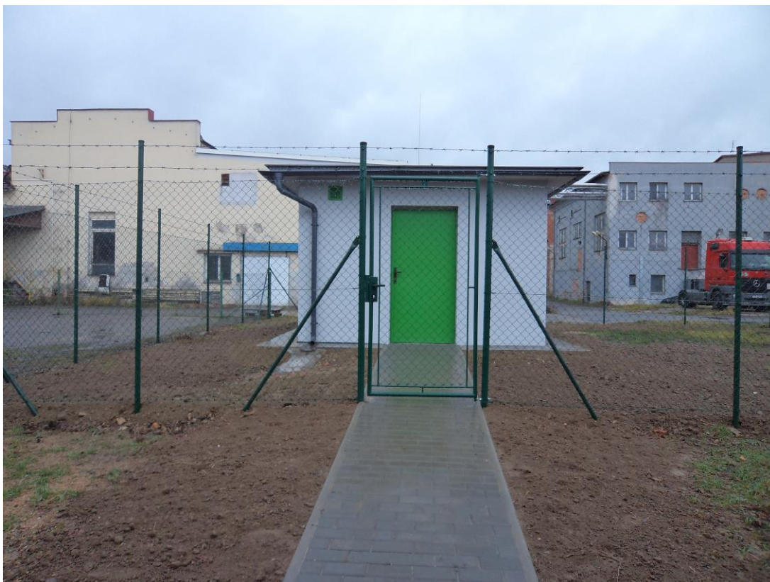
Obr. č. 35, Pohled na budovu vrtu Perla 06, (vlastní fotografie)
