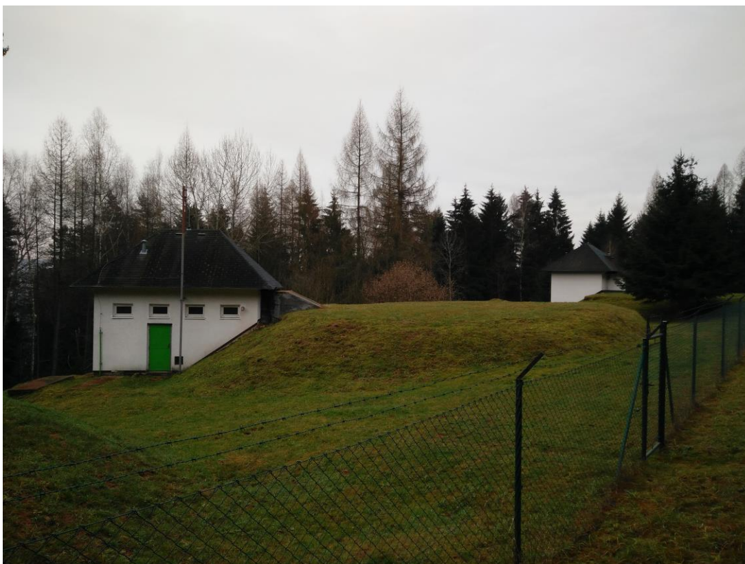
Obr. č. 38, Vodojemy horního tlakového pásma, (vlastní fotografie)
