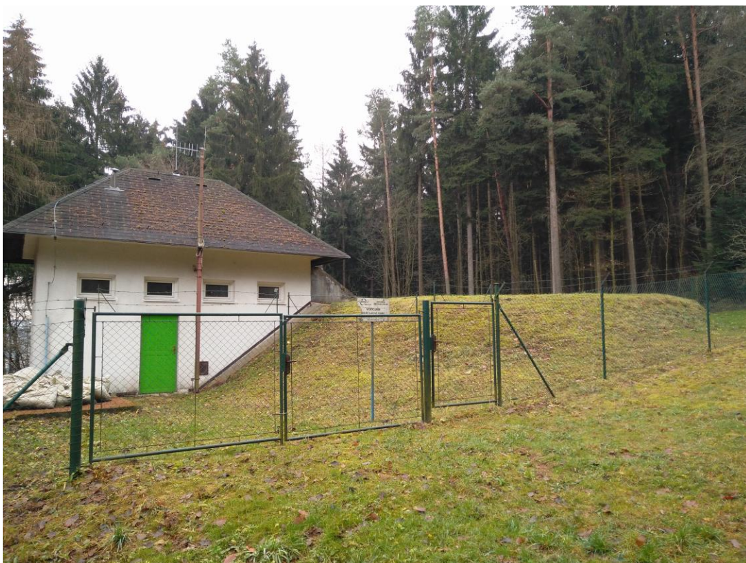
Obr.č.37, Vodojem dolního tlakového pásma, (vlastní fotografie)
