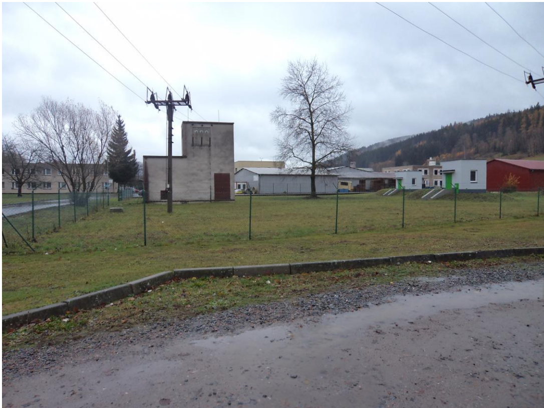
Obr. č. 34, Pohled na vrty UO-1 a UO-2 s oplocením ochranného pásma, (vlastní fotografie)
