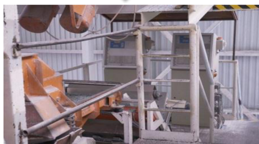
Konečné vyčištění pomocí optoelektronického zařízení
