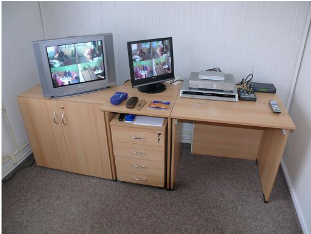
Foto č. 1 – pohled na technickou část výslechové místnosti
