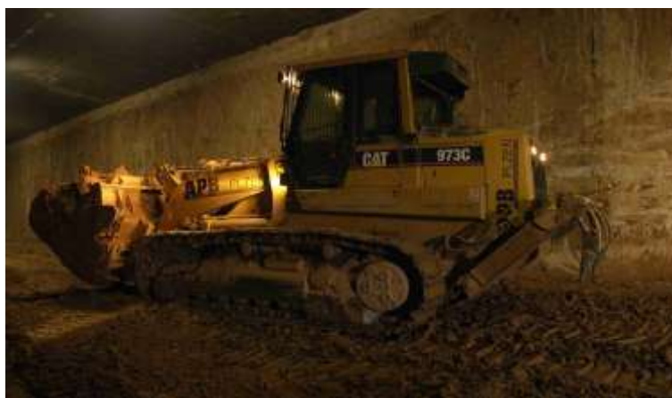
Obr. č. 18 - Milánské ražení tunelu – Cat 973
