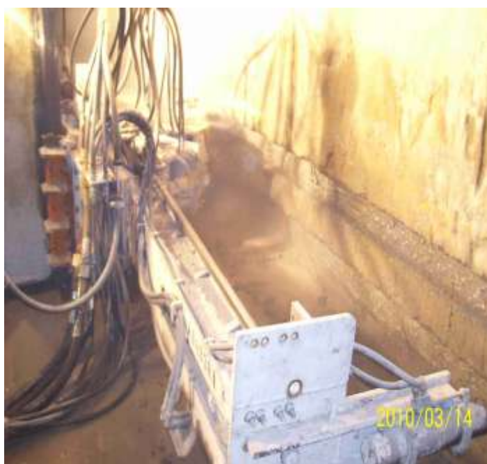
Obr. č. 21 - Frézování drážek do mil. Stěn – lafeta
