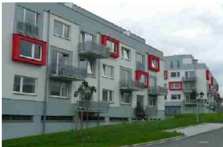
Obr. č. 12 - Bytové domy Plzeň – Černice [9]
