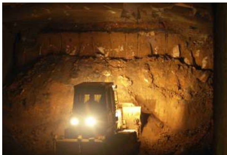
Obr. č. 19 - Milánské ražení tunelu – Cat 973
