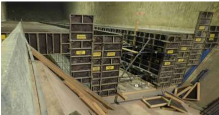
Obr. č. 28 - Systémové bednění Doka
