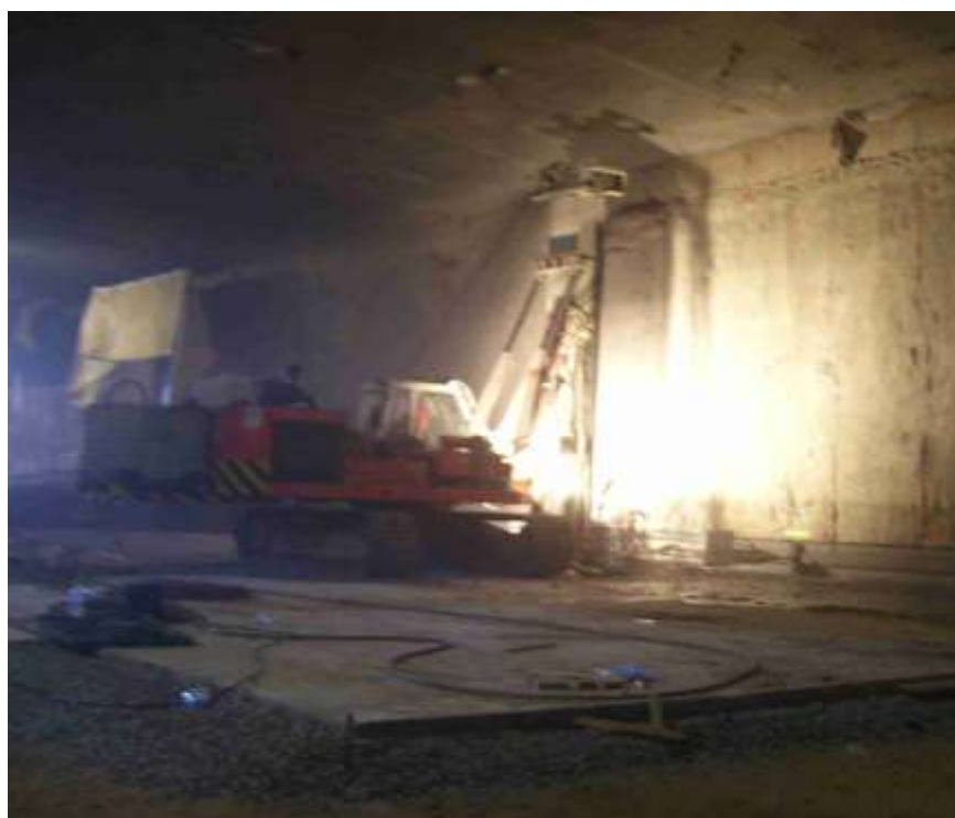
Obr. č. 22 - Frézování drážek do mil. Stěn
