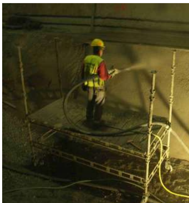
Obr. č. 23 a 24 Stříkání podkladních betonů
