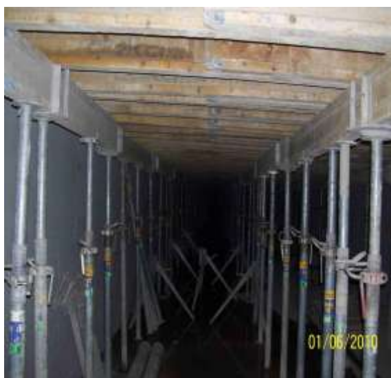
Obr. č. 31 a 32 - Bednění mostovky
