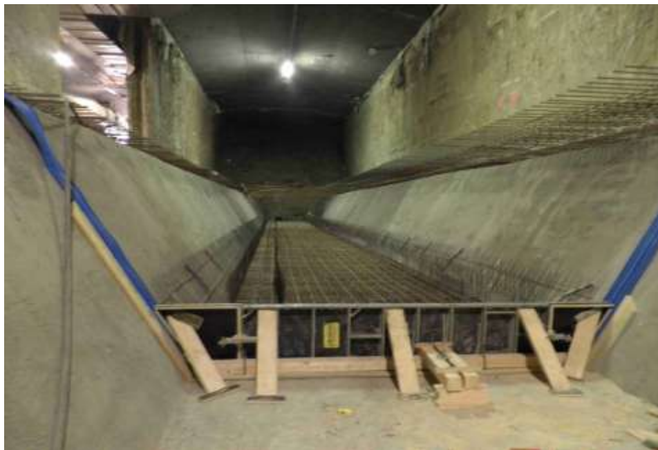
Obr. č. 25 - Spodní základová deska před betonáží
