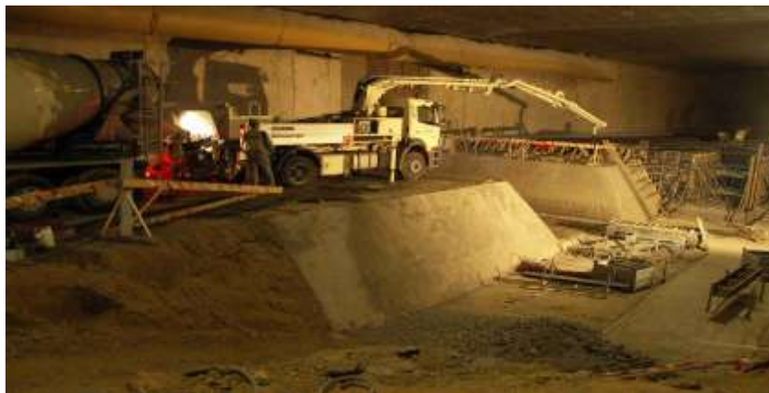
Obr. č. 30 - Betonáž horní základové desky
