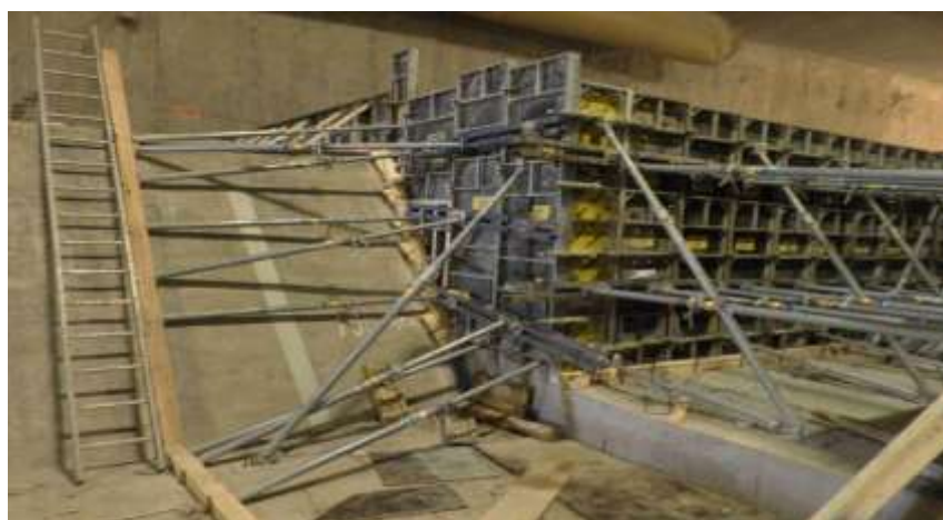
Obr. č. 29 - Bednění horní základové desky
