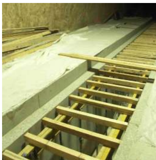
Obr. č. 31 a 32 - Bednění mostovky
