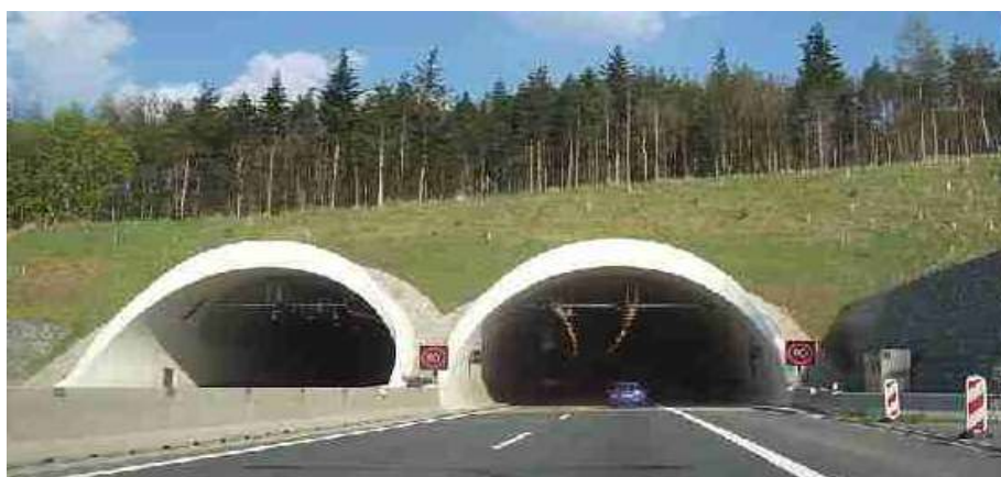
Obr. č. 14 - Tunel Valík [11]
