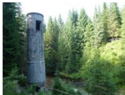
Foto č. 19 Šoupátková věž protržené přehradě
