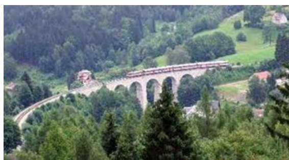
Foto č. 17 Viadukt ve Smržovce
