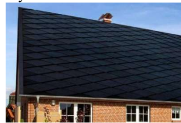
Obrázek 19 Samotná střešní krytina
