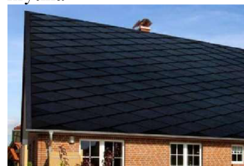
Obrázek 19 Samotná střešní krytina
