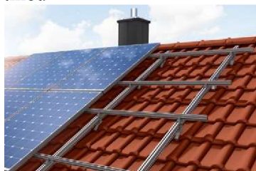
Obrázek 17 Nad střešní krytinou
