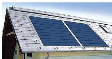
Obrázek 18 Integrace ve střešní krytině
