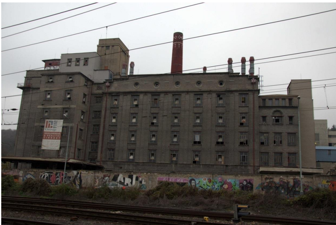
Obr. č. 7: Budova zachovávaného automatického mlýna – dominanta řešeného území. zdroj: (autor)
