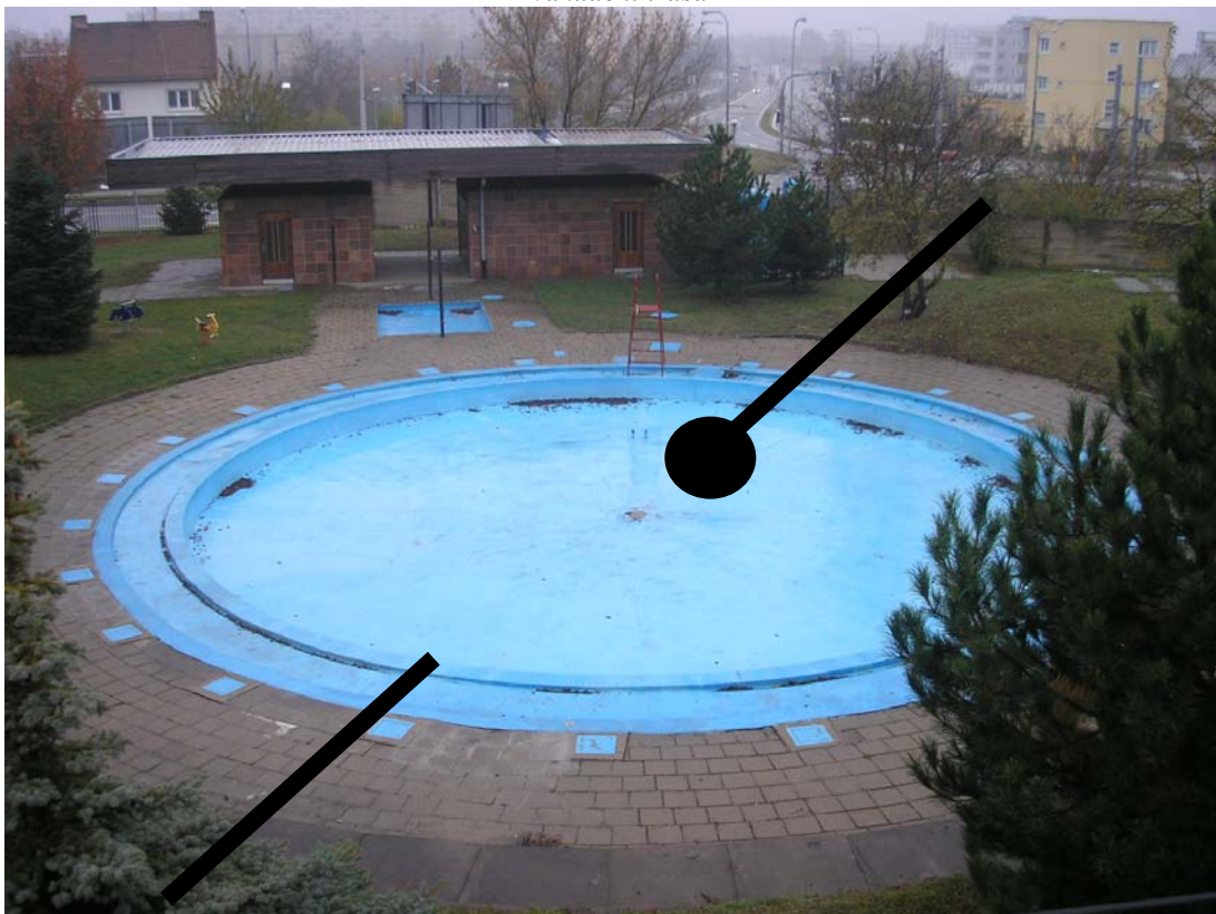
Nádrž na kontaminovanou vodu
