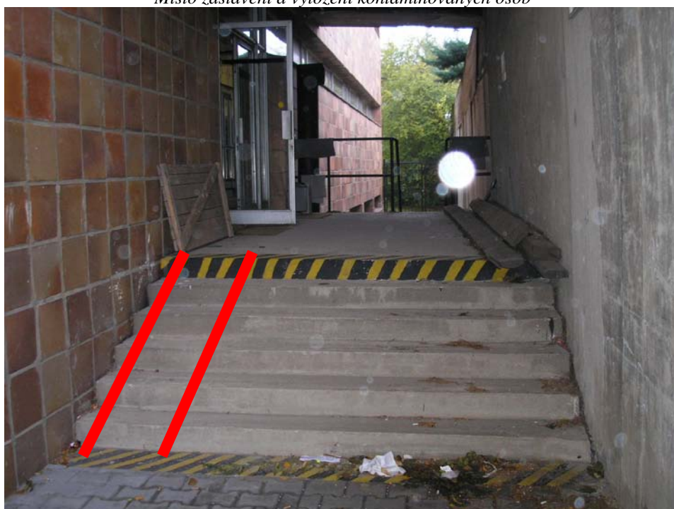
Vstup na stadion. Místo pro vybudování rampy pro imobilní osoby
