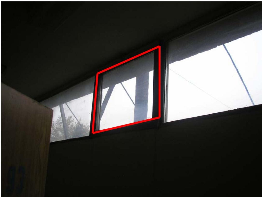
Okno pro vyhazování pytlů s kontaminovaným materiálem
