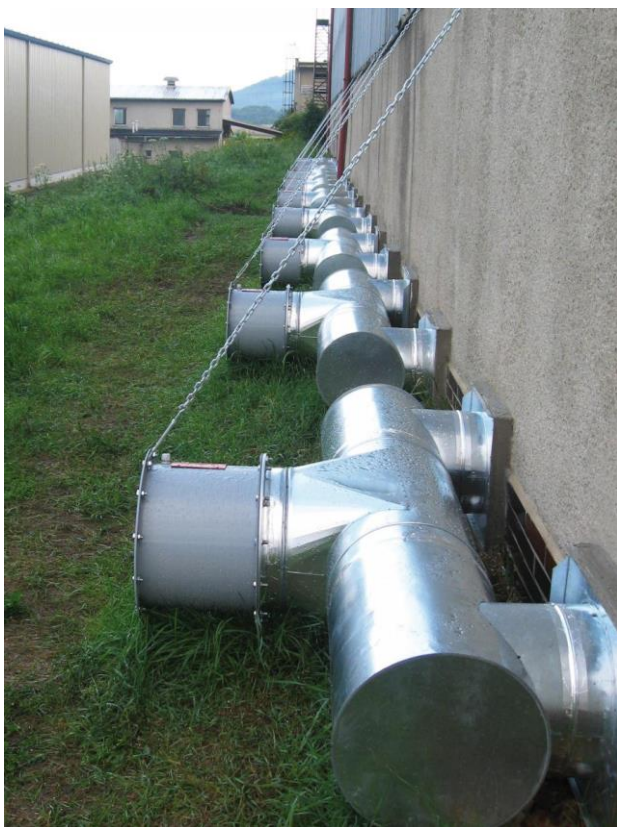
Obrázek 5 – Umístění ventilátorů napojených na podlahové větrání. [1]
