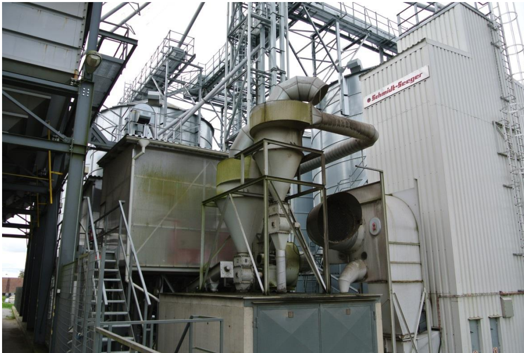
Obrázek 2 – mechanické odstředivé odlučovače prachu
