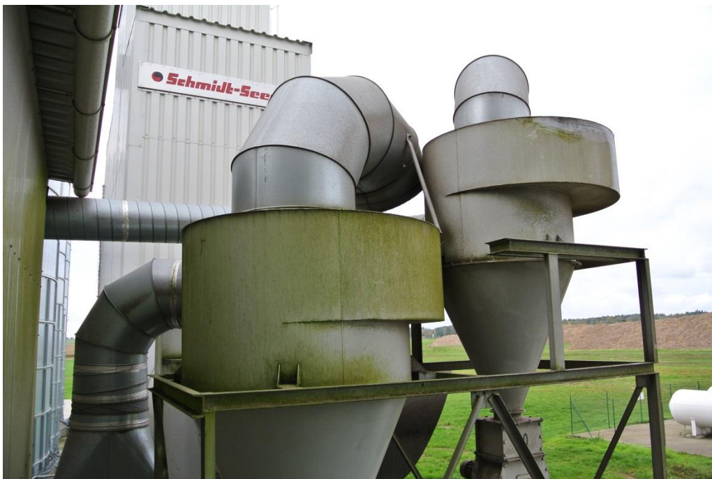
Obrázek 3 – mechanický odlučovač prachu(cyklon) – pro předčističku SMA 202(vlevo), pro čističku TAS 152A - 2 (vpravo)
