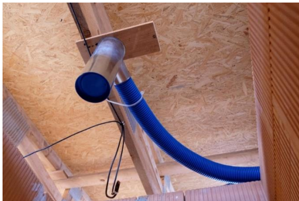
Obrázek 16: Plastová hadice ED FLEX 90 a průchozí stropní box
