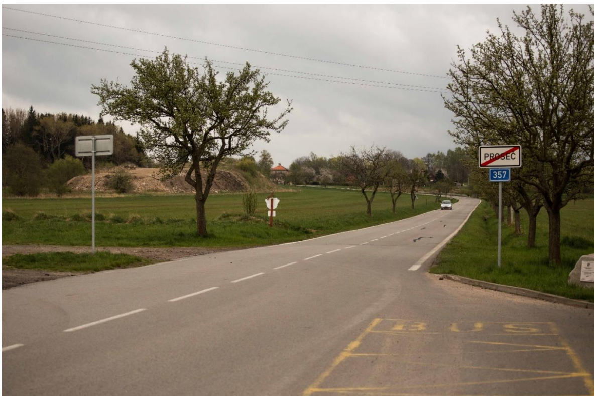
Obr. č. 4 : Pohled na první úsek měření
