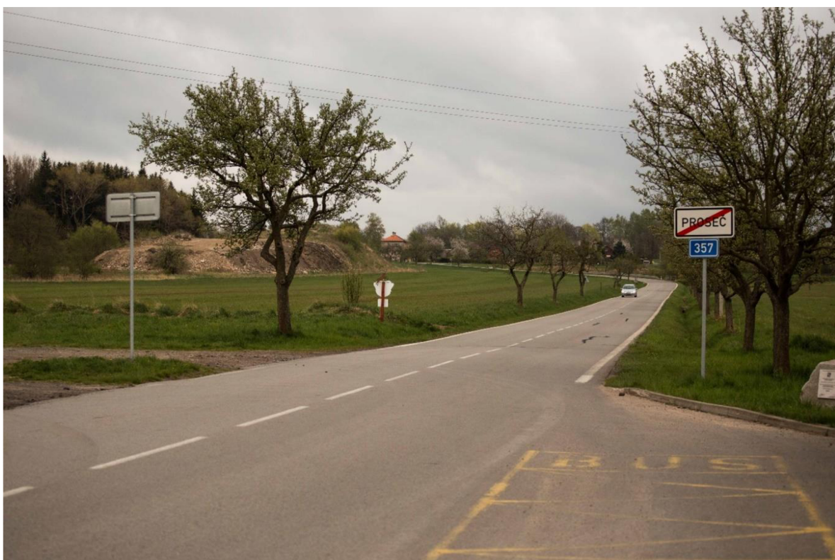
Obr. č. 4 : Pohled na první úsek měření
