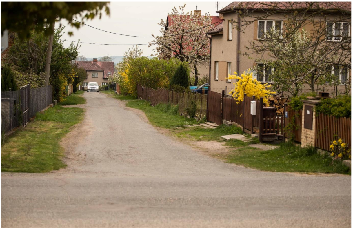
Obr. č. 10: Pohled na čtvrtý úsek měření
