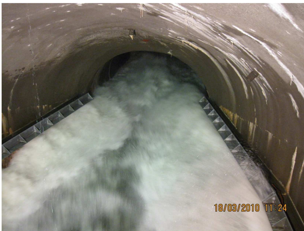
Obrázek 2 - Použití horizontálního deflektoru ve štole spodních výpustí VD Souš [3]
