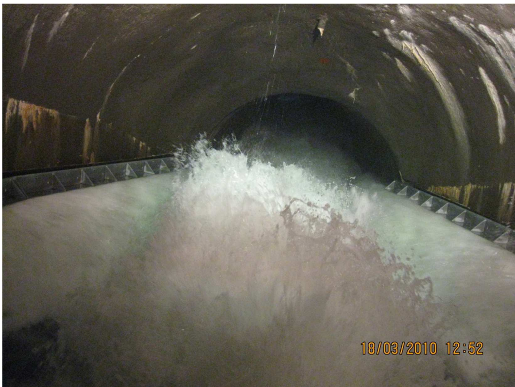
Obrázek 13 - Funkce deflektorů při provozu na díle [3]
