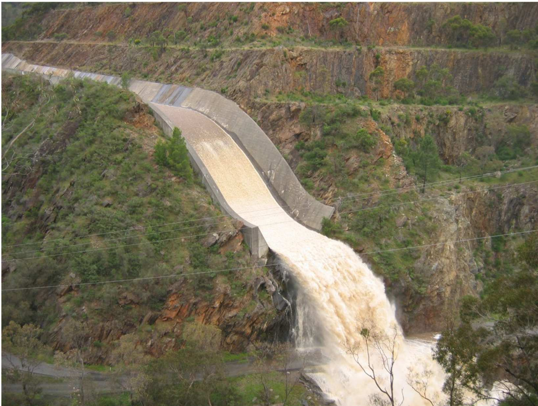
Obrázek 18 - Nadkritické proudění skluzem na přehradě Kangaroo v Austrálii [8]
