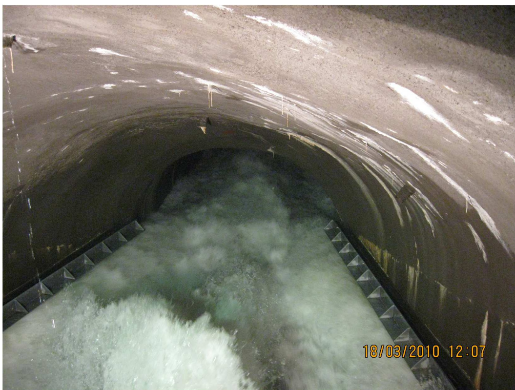
Obrázek 66 - Příklad úspěšně používaných usměrňovačů na VD Souš [3]
