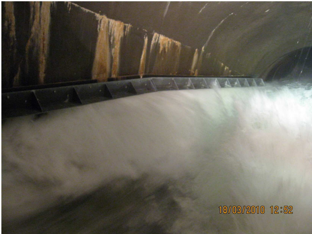
Obrázek 12 - Funkce horizontálního deflektoru při provozu [3]
