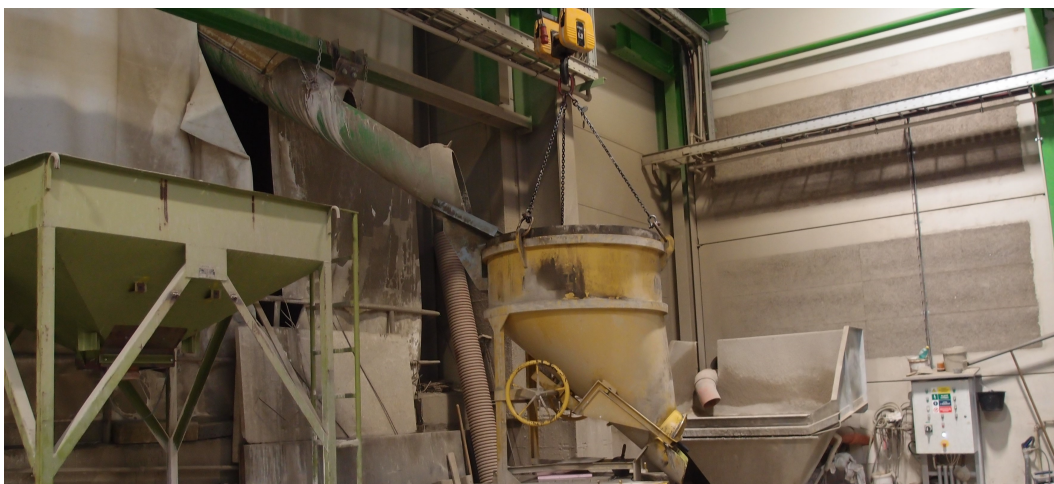
Obr. 1.7: Plnění bádíe čerstvým betonem
