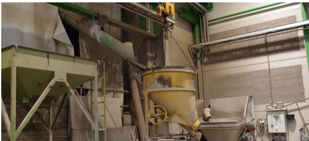
Obr. 1.7: Plnění bádíe čerstvým betonem
