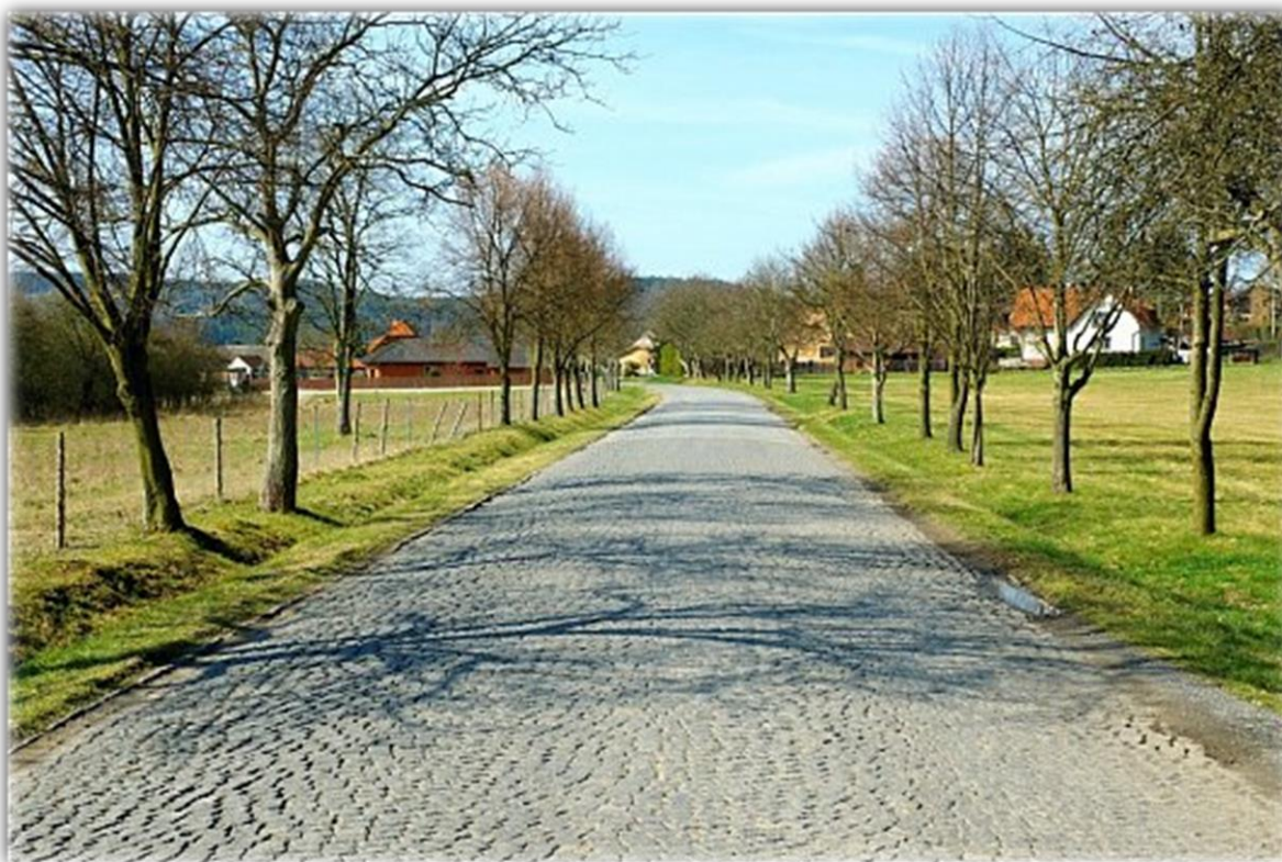
Obr. 48 Cesta, povrchová úprava kamenná dlažba.
