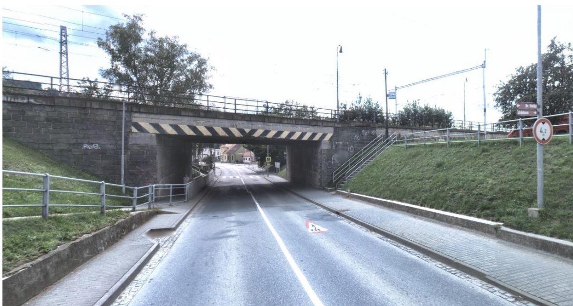
Obr. 10: B2 Podjezd pod železničním mostem na ulici Legionářská v Kuřimi (upraveno autorem) [4]
