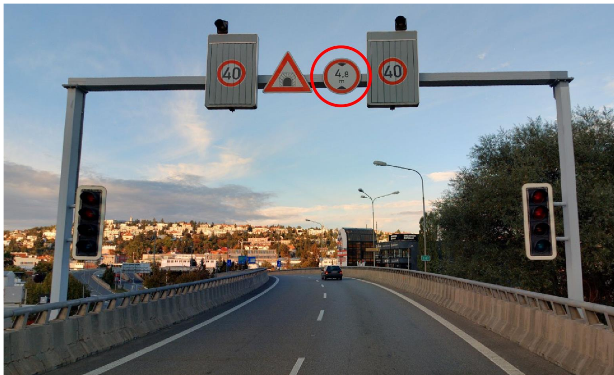
Obr. 26: D5 Průjezd tunelem Hlinky (upraveno autorem) [4]
