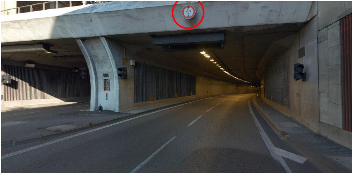
Obr. 27: D6 Průjezd Královopolským tunelem (upraveno autorem) [4]
