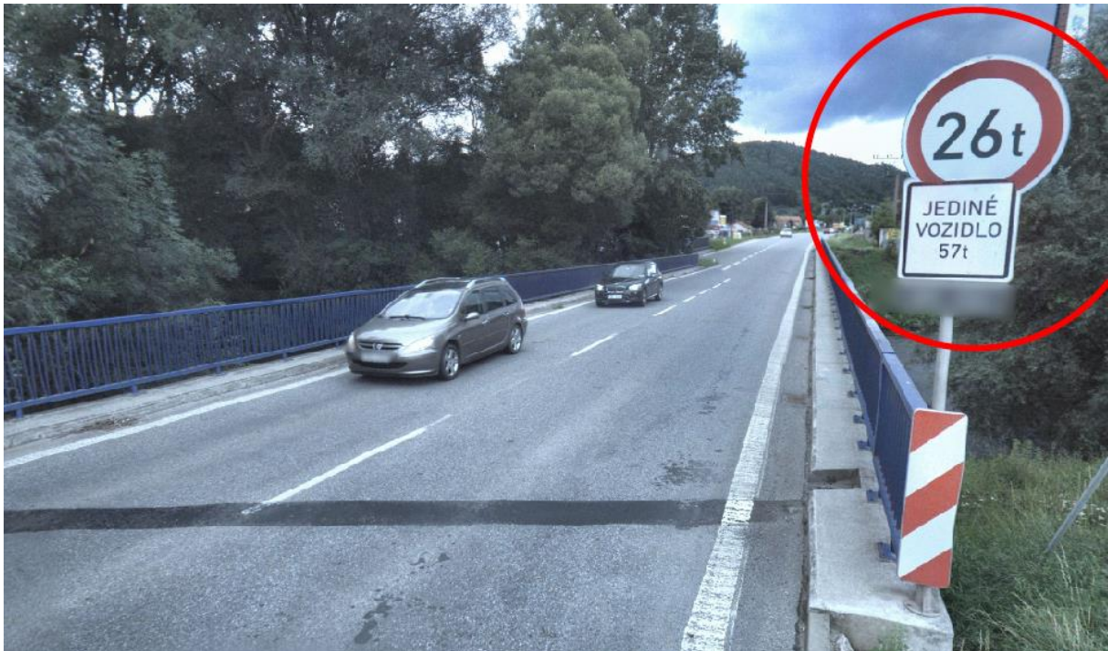
Obr. 11: B3 Přejezd po mostě přes Svatku (upraveno autorem) [4]
