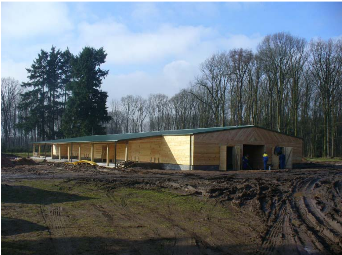
Výstavba nové odchovny
