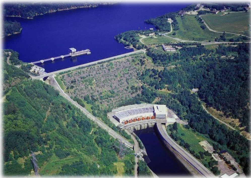
Obrázek 4.1: Přečerpávací vodní elektrárna Dalešice na úpatí sypané hráze [25]
