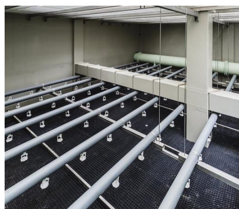
Obrázek 4.9: Rozstřík vody + chladicí výplň [28]
