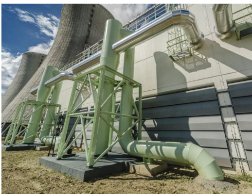
Obrázek 4.8: Výškový sifon + žaluzie [28]
