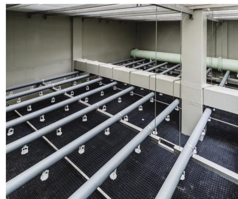
Obrázek 4.9: Rozstřík vody + chladicí výplň [28]
