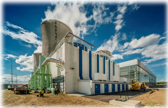
Obrázek 1: Ventilátorové věže v Jaderné elektrárně Dukovany [1]
