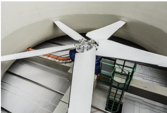
Obrázek 4.6: Ventilátorové soustrojí [28]
