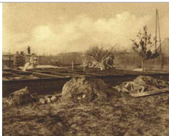
10.00 : Položení základových prahů
