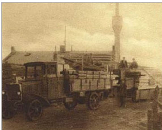
8.00 : Příjezd na staveniště
