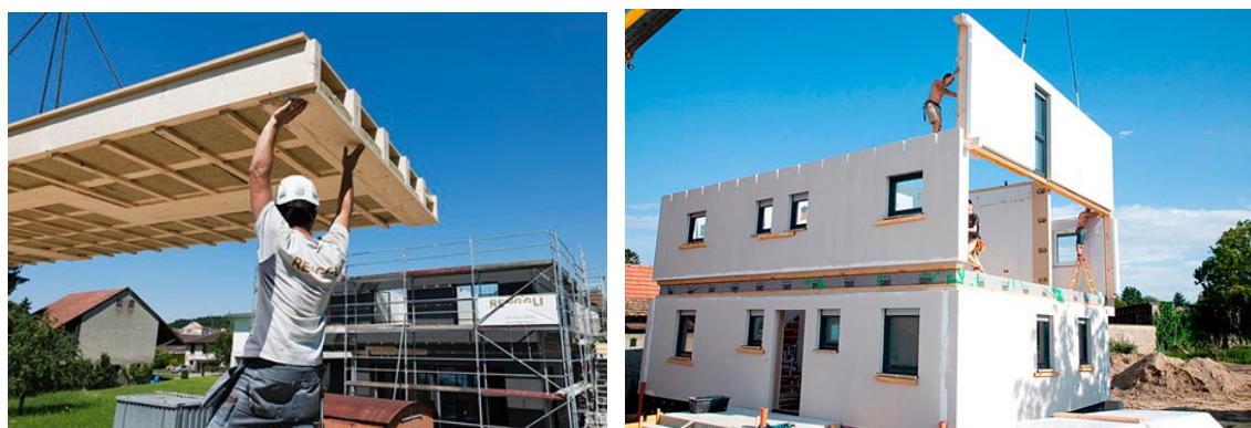
Obr. 23 a 24 – Montáž na staveništi (Zdroj: renggli.swiss)
