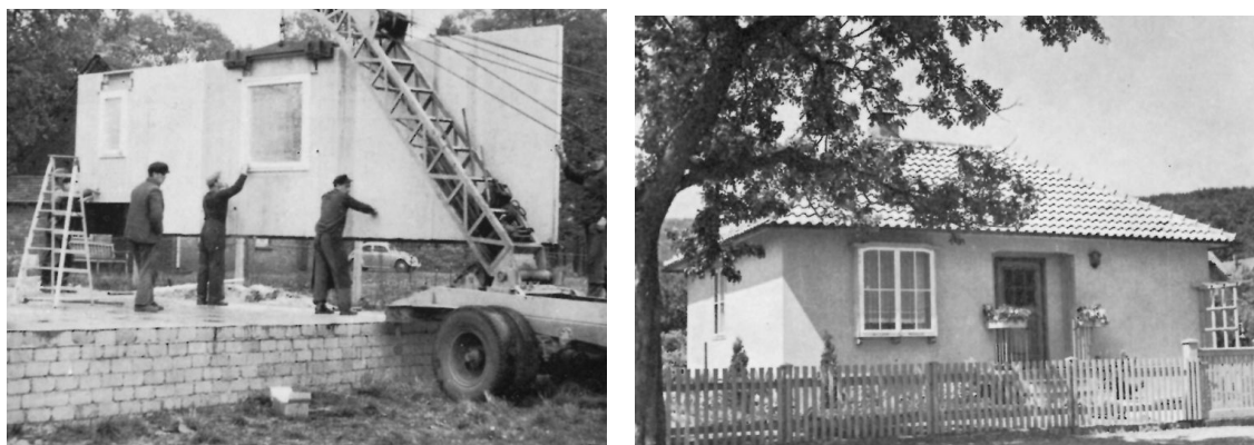
Obr. 14 – OKAL, montáž a první smontovaný dům, 1953 (Zdroj: OKAL.de)
