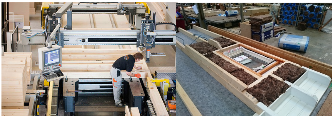
Obr. 21 a 22 – Výroba stěnových a střešních panelů (Zdroj: FingerHaus.de)
