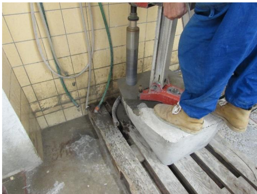
Obr. 12 Získávání zkušebních těles jádrovým vrtáním (LB2).
