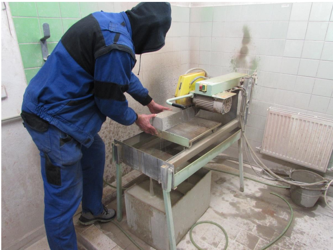
Obr. P14 Řezání základních těles – experiment č. 2.
