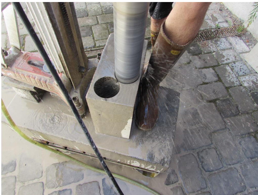
Obr. P3 Průběh jádrového vrtání na LB1 – vývrt z dlaždice.
