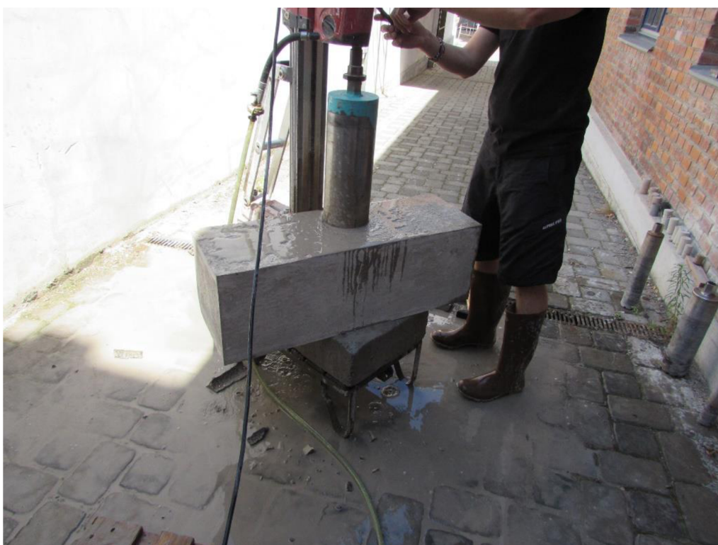
Obr. P4 Průběh jádrového vrtání na LB1 – vývrt z T300/900.
