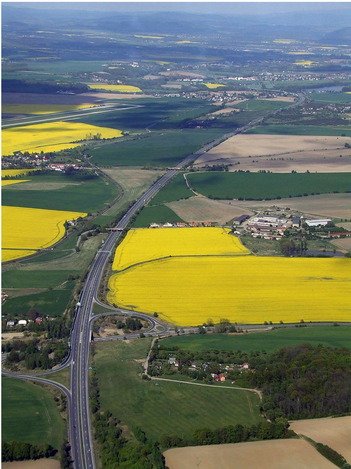
Zdroj: Jan Sovka aka sovicka, 2007: Rychlostní silnice R10 - Exit Mnichovo Hradiště
