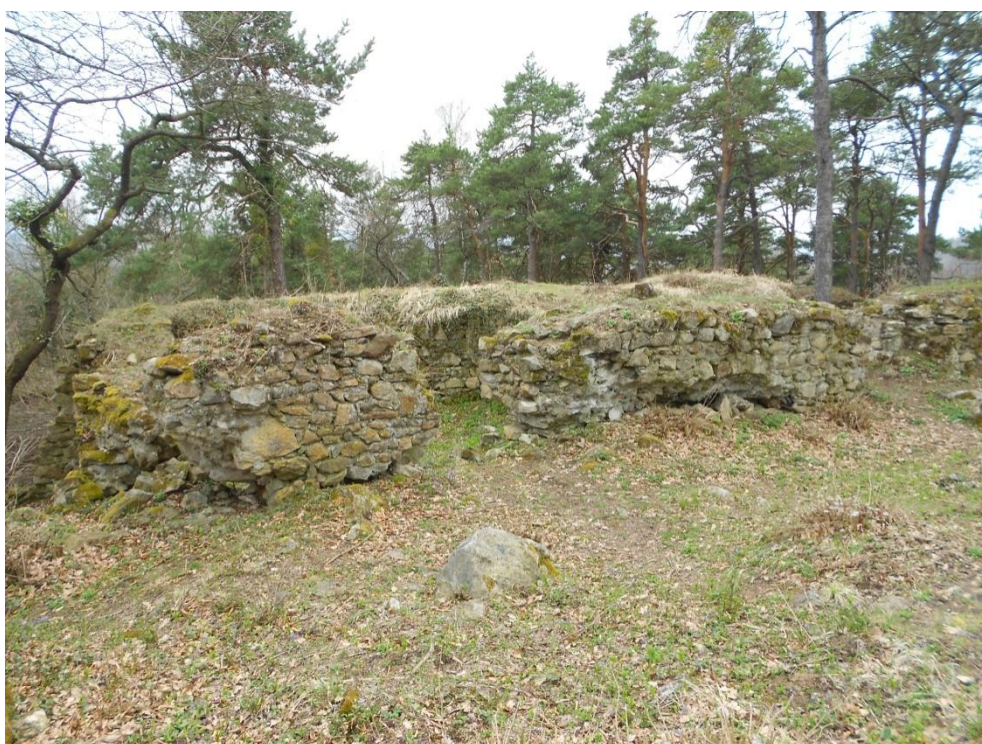
Obr. 72 – Vitějovice, rovné koruny zdí svědčí o zastavení stavebních prací v úrovni prvního patra ( foto autor ).
