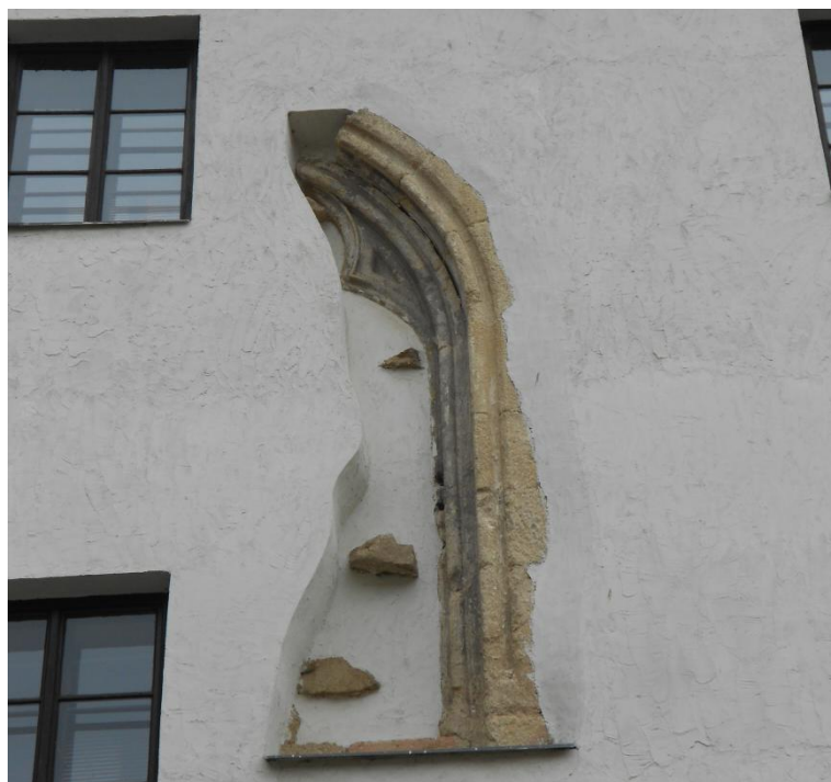
Obr. 53 – Písek, portál umožňující vstup do severního křídla ( foto autor ).
