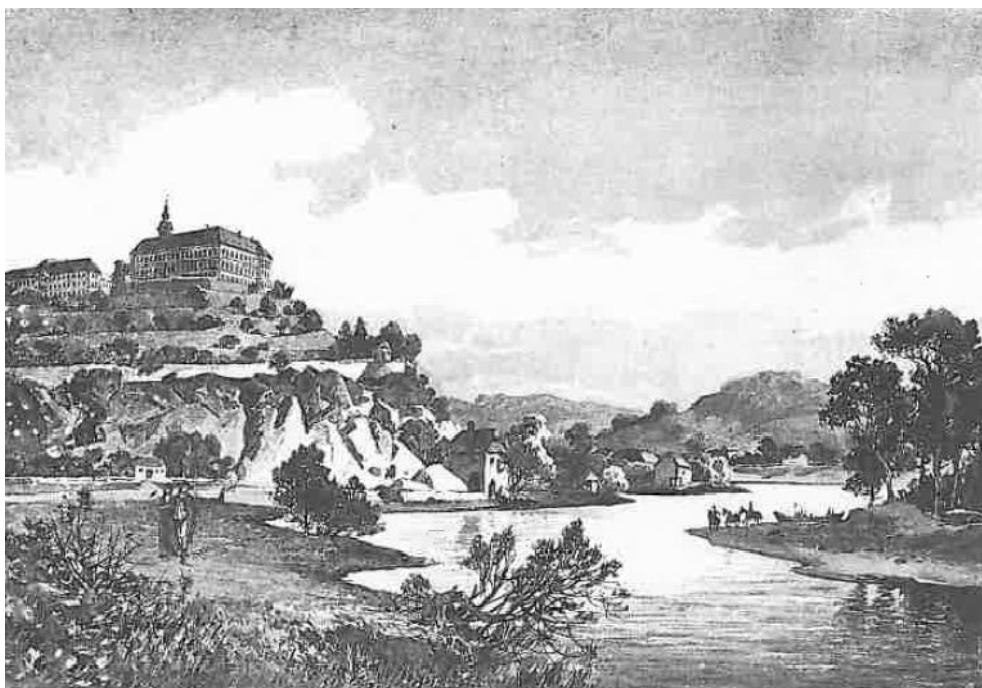
Obr. 13 – Podoba zámku Hluboká před novogotickou přestavbou, pohled od jihu (převzato z Sedláček 1997, 128).
