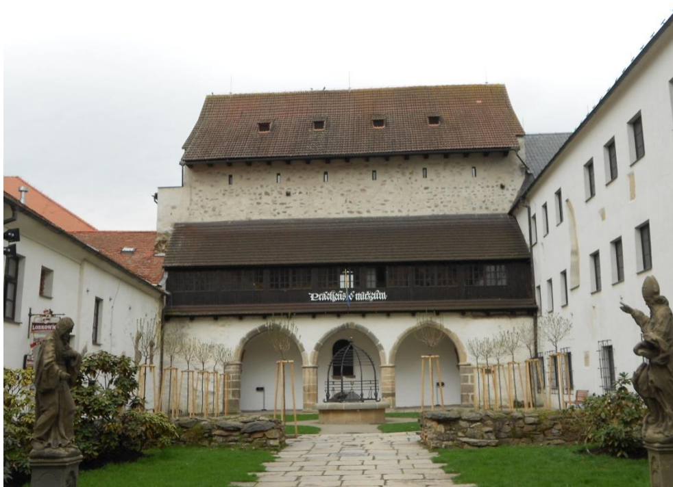
Obr. 48 – Západní křídlo Hradu v Písku, pohled od východu (foto autor).
