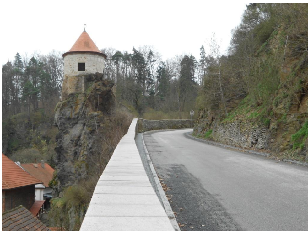
Obr. 5 – Bechyně, věž zvaná „Kohoutek“ pohled od severu (foto autor).
