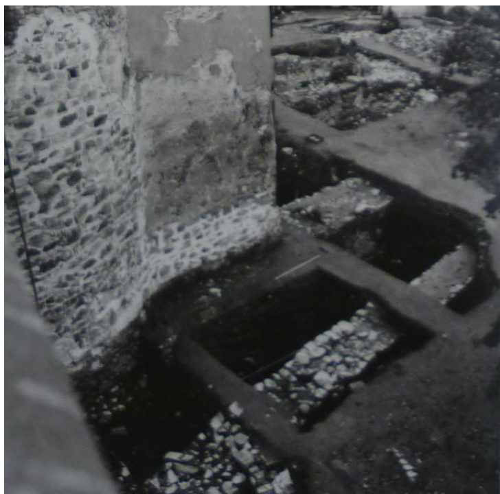
Obr. 25 – Pohled do sond 1, 3, 5 kde je patrná obvodová zeď a parkánová hradba hradu Hradiště (převzato z Krajíc 1993, zpráva o výzkum č.j. 1115/94 ).
