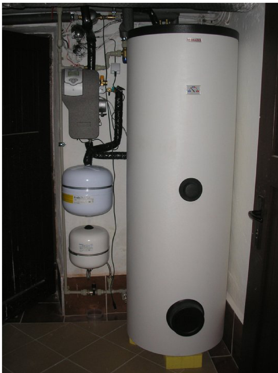
Obr. 22 Nepřímotopný ohřivač Dražice OKC 300 NTRR/1MPa
