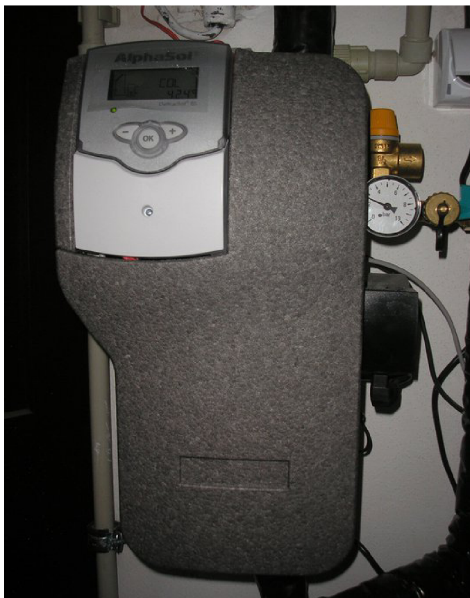
Obr. 18 Oběhové čerpadlo s řídicí jednotkou Resol DeltaSol BS Plus
