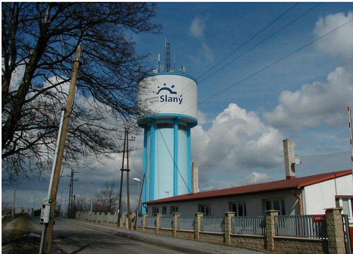
Obr. 5 - Věžový vodojem Slaný - Háje
