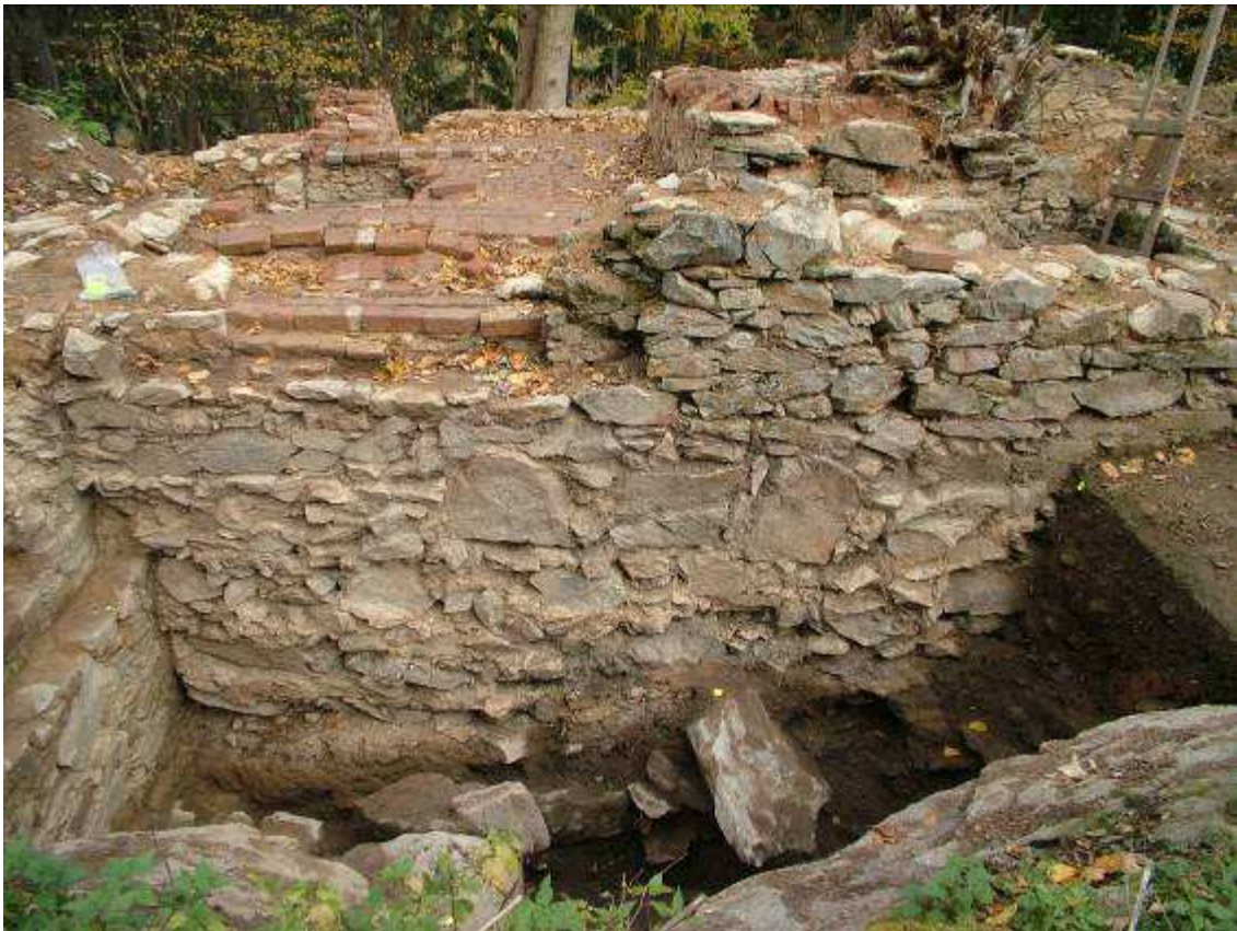
Obr. 28 - Pohled na sondy IV a III, foto autor výzkumu.
