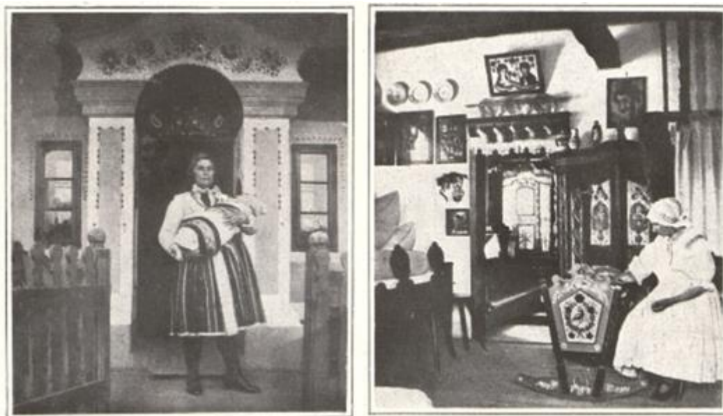
78. Uherské Hradiště – Mařatice, ulice Příčná II., vstupní žudro a interiér „Moravsko-slovenské“ chalupy čp. 273, 1921, architekt Antonín Šupka, stavebník Ladislav Rutte.
