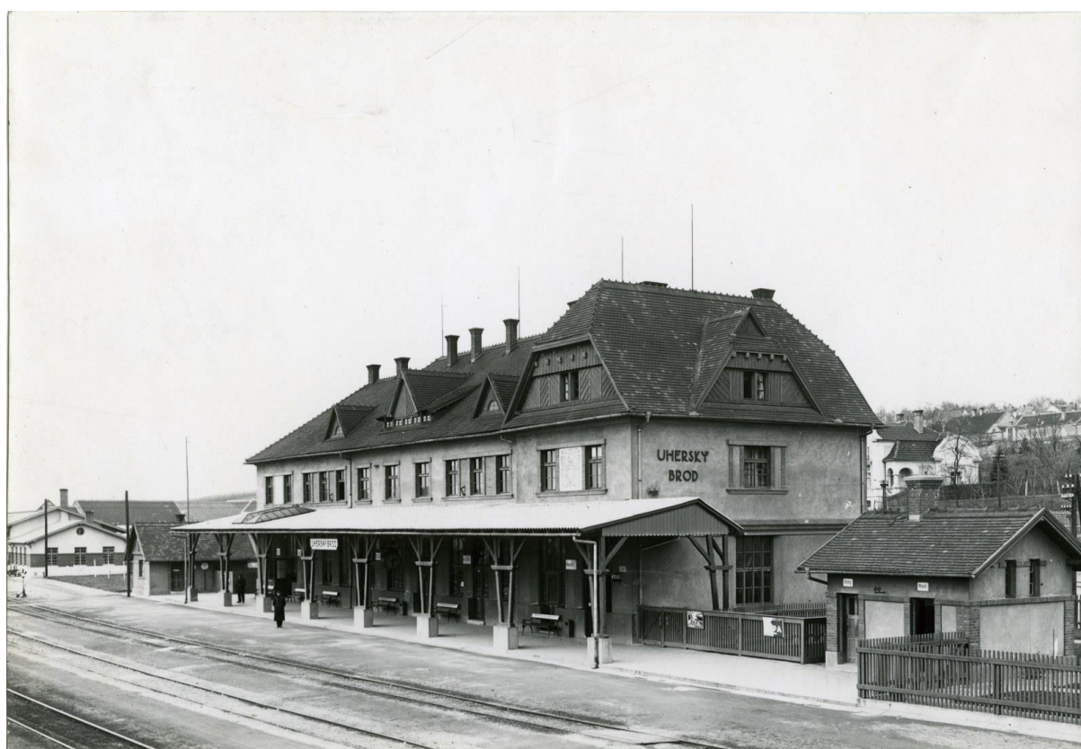
188. Uherský Brod, výpravní budova, 1927, projekt Václav Pokorný, pohled od kolejiště.
