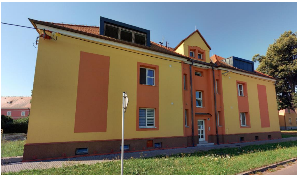
103. Uherské Hradiště, činžovní nouzový dům čp. 395, 1922, stavitel Josef Horák, pohled od severu.
