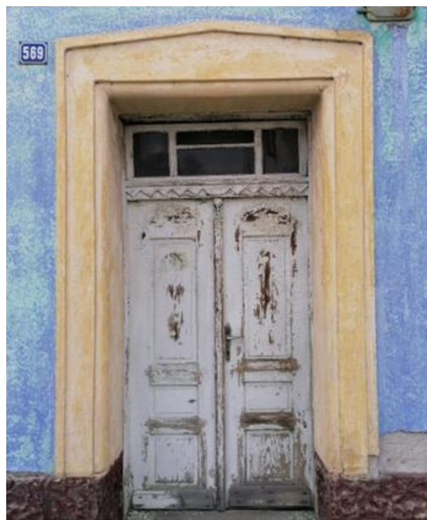
373. Blatnice pod Svatým Antonínkem, detail dveří domu čp. 569, první polovina 20. století.
