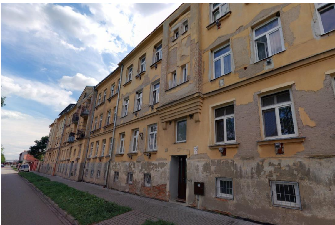
218. Břeclav, obytné komplex v ulici Na Zahradách, dvacátá léta 20. století, pohled od severovýchodu.
