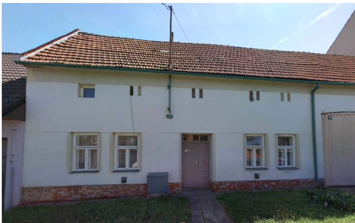
242. Mistřice, dům čp. 270 s jednoduchými svislými párovými průduchy, první polovina 20. století., pohled od severozápadu.
