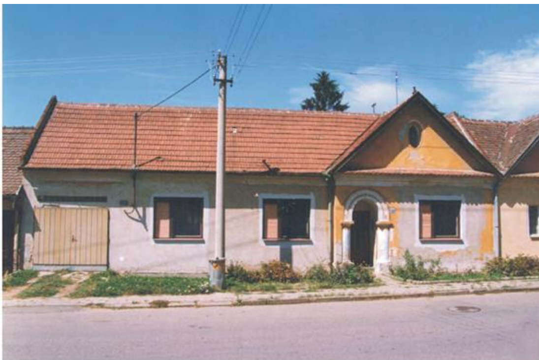
198. Uherský Brod – Havřice, domy ovlivněné secesním historismem - čp. 1006 na ulici Svatopluka Čecha, počátek 20. století, stavitel Cyril Kubíček (zbořeno).
