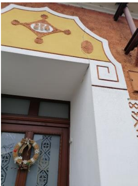
390. Kunovice, detaily domu čp. 274, kolem 1910–1915, pohled od jihozápadu.
