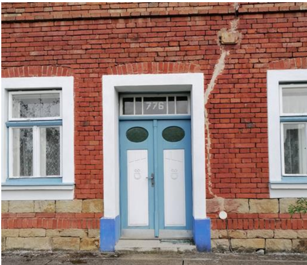
411. Vlčnov, detaily dveří a oken na domě čp. 776 v ulici Masarykova, dvacátá až třicátá léta 20. století, pohled od západu.
