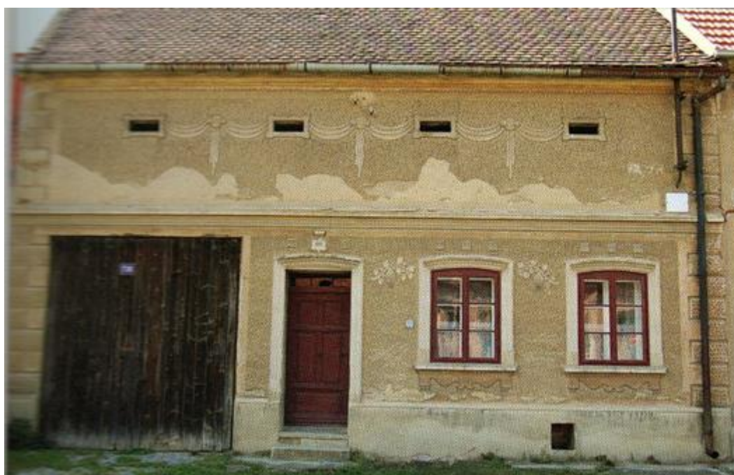
408. Vlčnov, zaniklý dům čp. 736 v ulici Masarykova, dvacátá až třicátá léta 20. století, pohled od východu.
