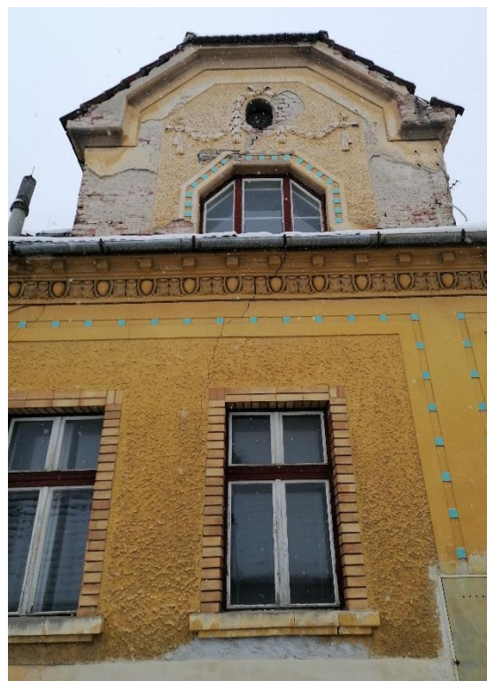
168. Uherský Brod, řadový dům čp. 53 v ulici Boženy Němcové pro manžele Sedlářovi, 1913, stavitel Karel Málek z Uherském Brodu, detail oken a vikýře, pohled od východu.
