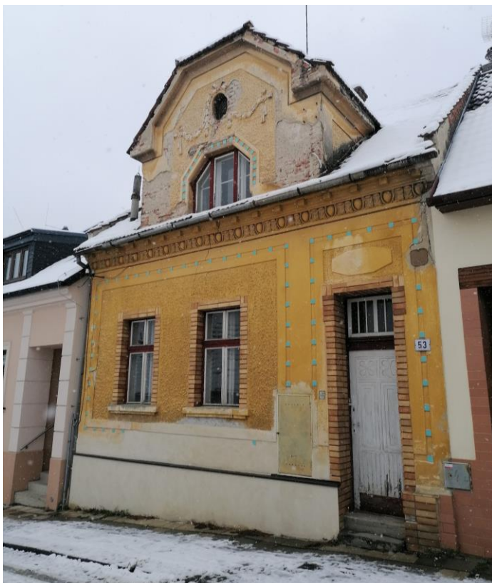
166. Uherský Brod, řadový dům čp. 53 v ulici Boženy Němcové pro manžele Sedlářovi, 1913, stavitel Karel Málek z Uherském Brodu, pohled od východu.
