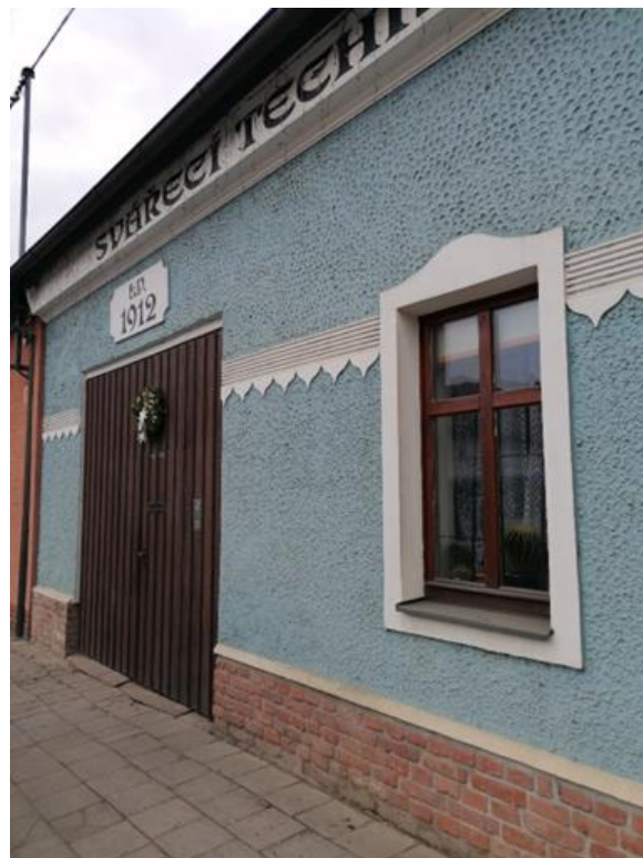
385. Kunovice, dům čp. 238 v ulici Husitská s původním členěním fasády po renovaci, 1912, pohled od severovýchodu.
