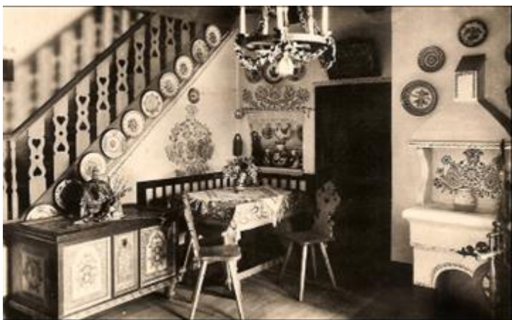
77. Uherské Hradiště – Mařatice, ulice Příčná II., interiér rodinného domu čp. 273, 1921, architekt Antonín Šupka, stavebník Ladislav Rutte.
