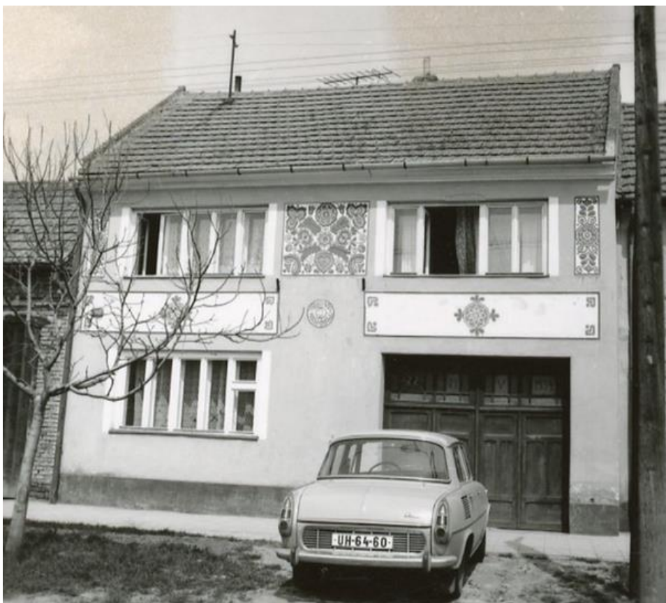
42. Hluk, dvoupodlažní dům čp. 22 na Dolním konci s folklorní výzdobou, 1934 (přestavěn).
