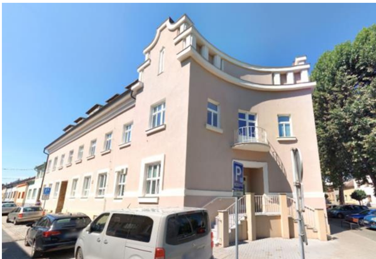
224. Kyjov, Okresní nemocenská pokladna na třídě Komenského čp. 740/51, 1926–1928, architekt Jan Mráček, stavitel Rudolf Rusňák, pohled od jihozápadu.
