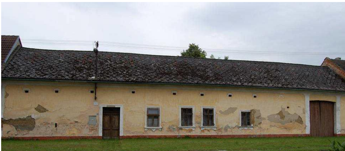
237. Kněžpole, dům čp. 15 s částečně zachovalou fasádou, první desetiletí 20. století, pohled od severozápadu.
