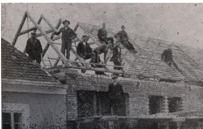
261. Strážnice, tesaři při stavbě domu, 1930.
