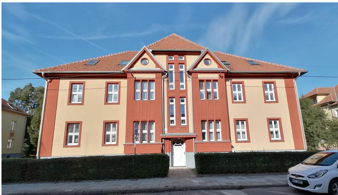
95. Uherské Hradiště, stavba činžovního nouzového domu čp. 372 v typu I, září 1919, stavební společnost Alois Jaroš a Command. v Uherském Hradišti, pohled od jihu.
