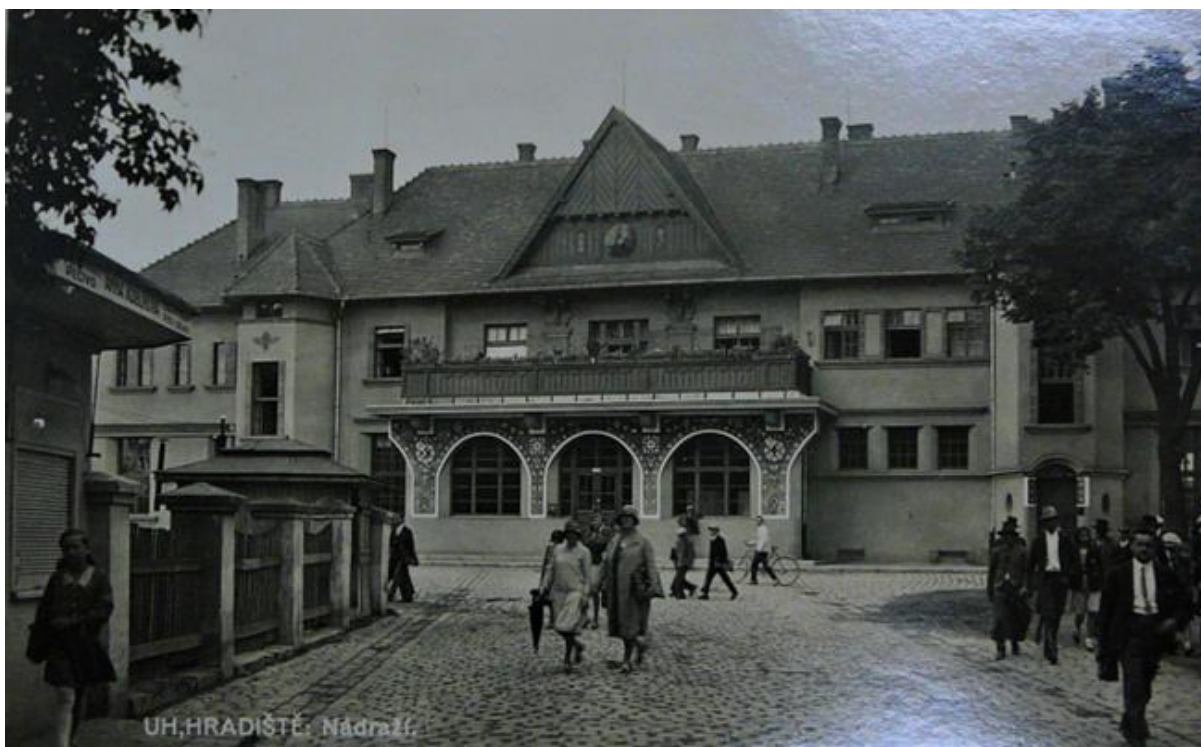
156. Uherské Hradiště, výpravní budova, třicátá léta 20. století, pohled od přednádraží.
