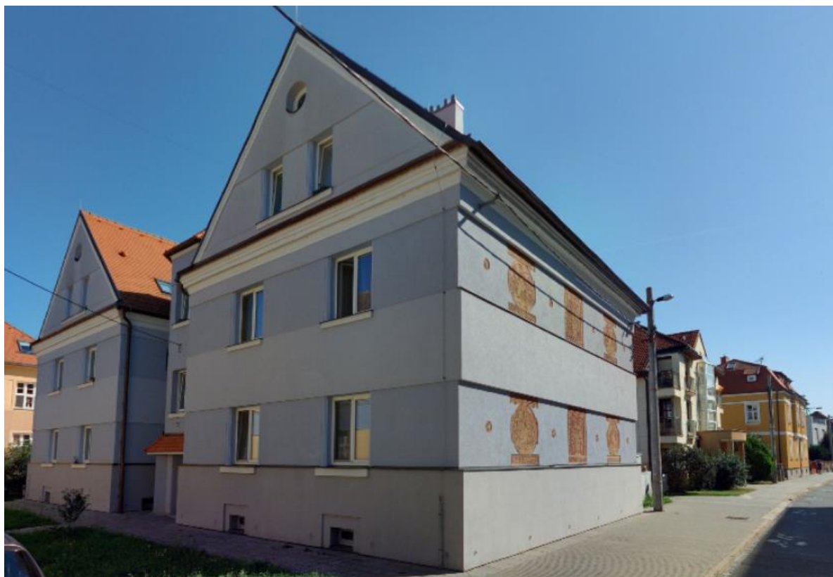
135. Uherské Hradiště, stavba obytného domu typ IX. v ulici Kollárova čp. 445, 1926–1927, pohled od jihozápadu.
