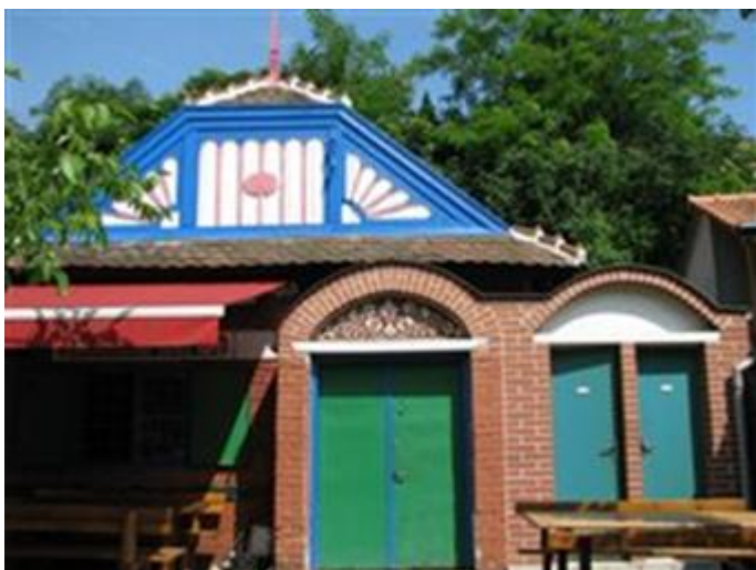
84. Kyjov, ulice U Sklepů, Švarcův sklep, 1926, pohled od západu.
