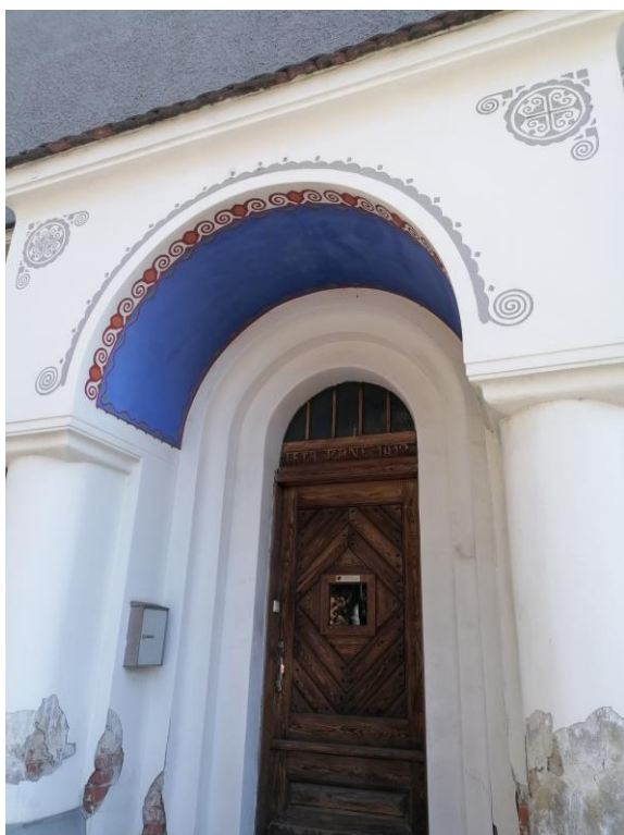
205. Hodonín, detail bočního vchodu na Domě umělců, 1913, architekt Antonín Blažek, pohled od západu.
