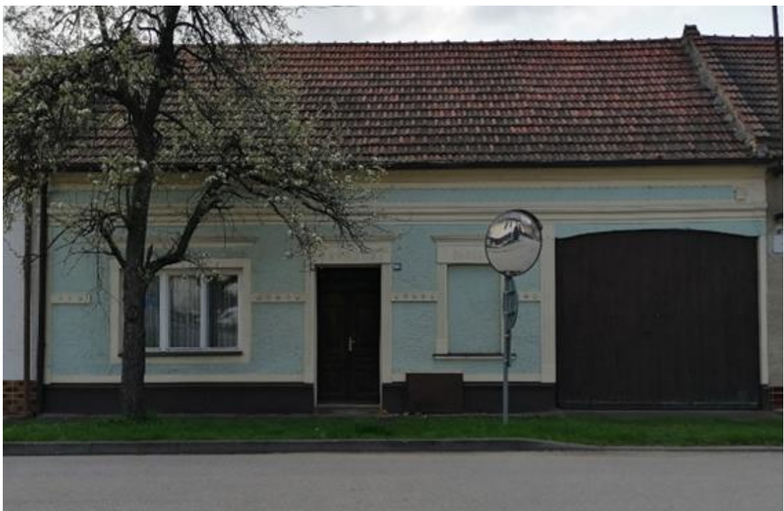
369. Blatnice pod Svatým Antonínkem, detail domu čp. 568, první polovina 20. století, pohled od severovýchodu.
