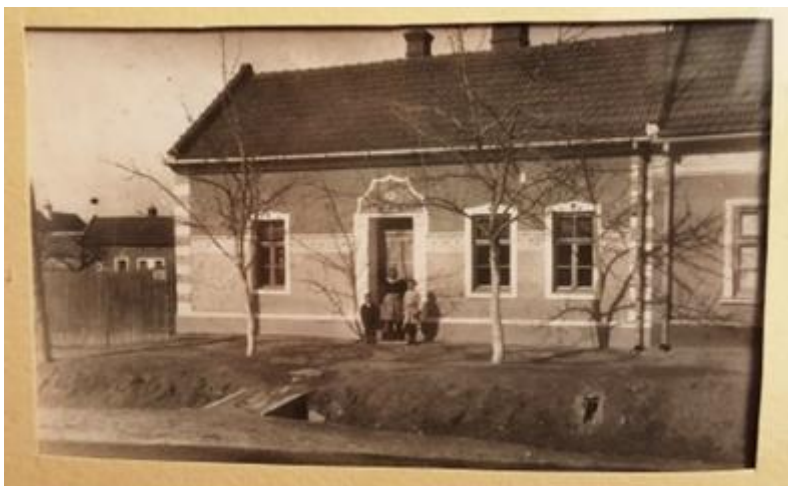
392. Kunovice, dům čp. 274 na dobové fotografii, kolem 1910–1915, pohled od jihu.
