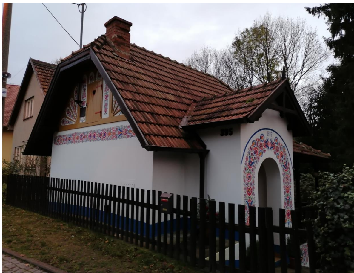
69. Uherské Hradiště – Mařatice, Vinohradská čp. 395, detail Benešova sklepa, 1912, stavitel Alois Cvach, pohled od severozápadu.
