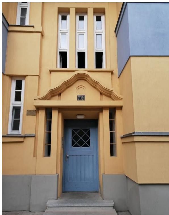
119. Uherské Hradiště, detail vstupu obytného domu typ VI.a v ulici Kollárova čp. 404, 1923–1927, pohled od východu.
