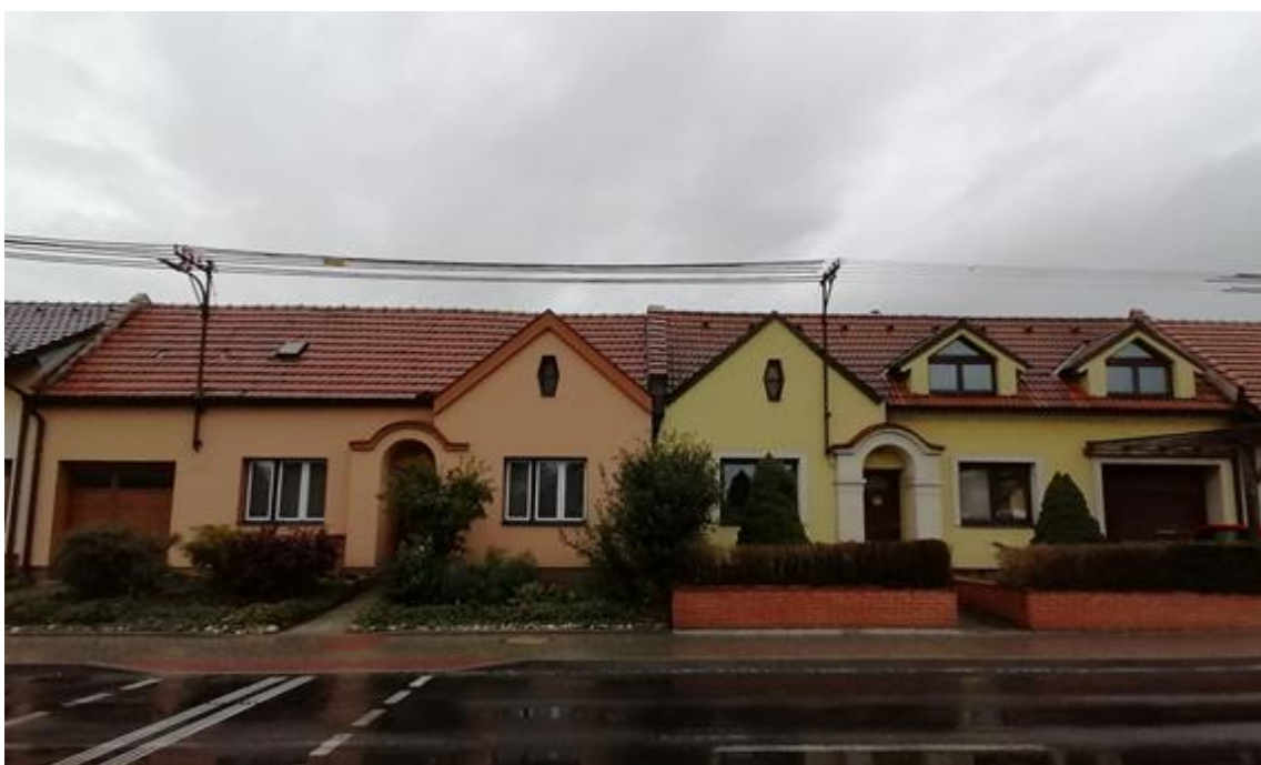
18. Uherské Hradiště – Sady, nové domy s žudry čp. 8 a 7 z protipovodňové akce postavené po roce 1920 a dokončené v roce 1925, pohled od jihu.
