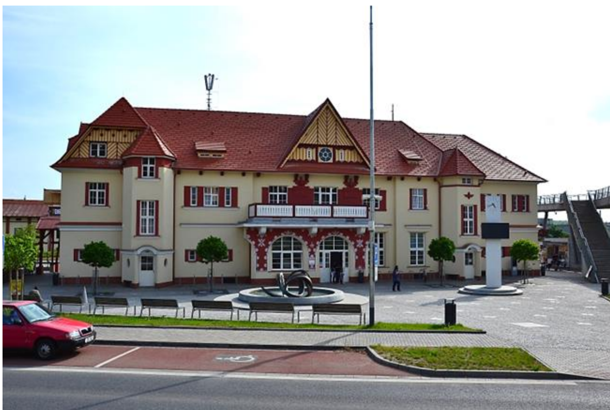
190. Uherský Brod, výpravní budova, pohled z přednádraží.
