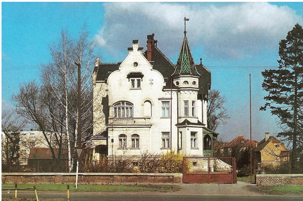
213. Břeclav, vila Ferdinanda Rossaka v ulici Lidická čp. 1060/4 (dnes Hvězdova vila), 1903, stavitel-stavebník Ferdinand Rossak, pohled od severozápadu.
