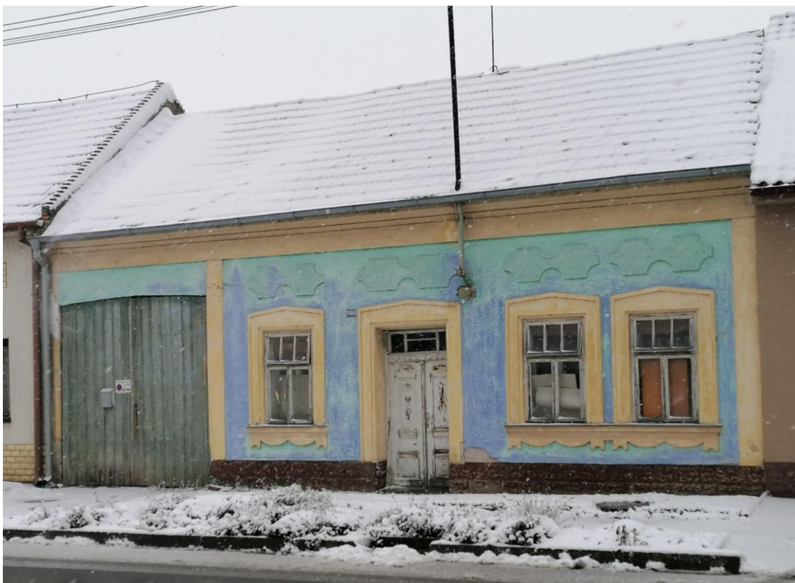
367. Blatnice pod Svatým Antonínkem, dům čp. 569, první polovina 20. století, pohled od východu.
