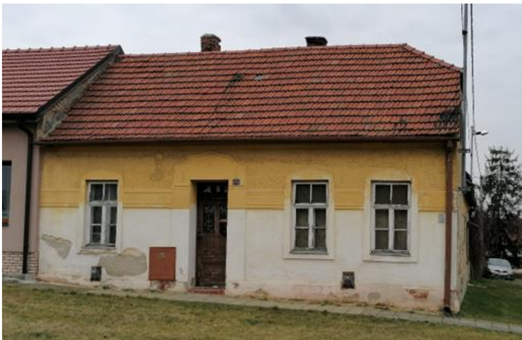
387. Kunovice, dům čp. 272 v ulici Šlerkova s pozdějšími úpravami fasády, kolem 1910–1915, pohled od východu.
