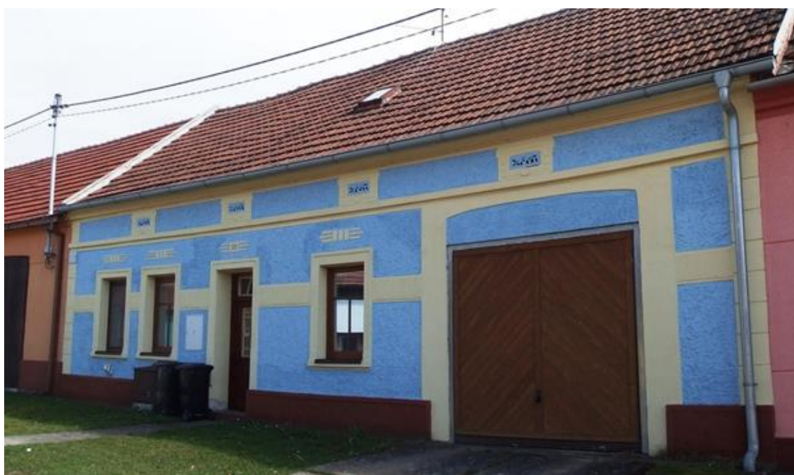
244. Horní Němčí, dům čp. 301 s větracími průduchy ve tvaru ratolesti a štukovou výzdobou, první polovina 20. století, pohled od severu.
