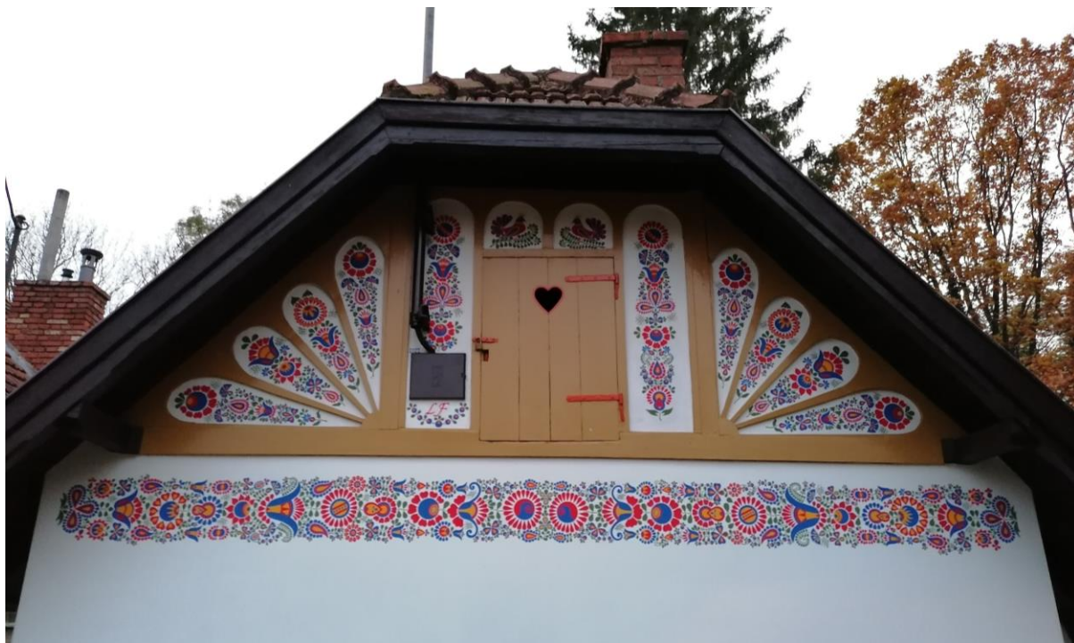
68. Uherské Hradiště – Mařatice, Vinohradská čp. 395, detail Benešova sklepa, 1912, stavitel Alois Cvach, pohled od severu.
