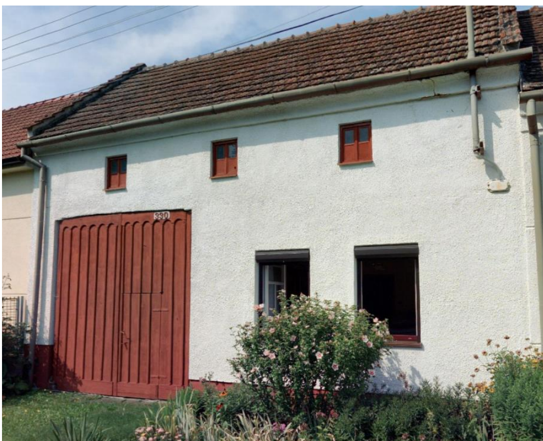
240. Horní Němčí, dům čp. 330 s větracími průduchy sýpkového polopatra ve tvaru vrátek a vraty napodobující obloučkový vlys, první polovina 20. století, pohled od východu.
