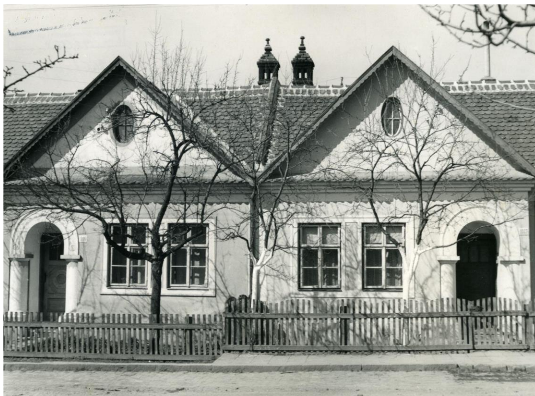
200. Uherský Brod – Havřice, domy ovlivněné secesním historismem - čp. 1006 a čp. 1007 na ulici Svatopluka Čecha, počátek 20. století, stavitel Cyril Kubíček (zbořeno).
