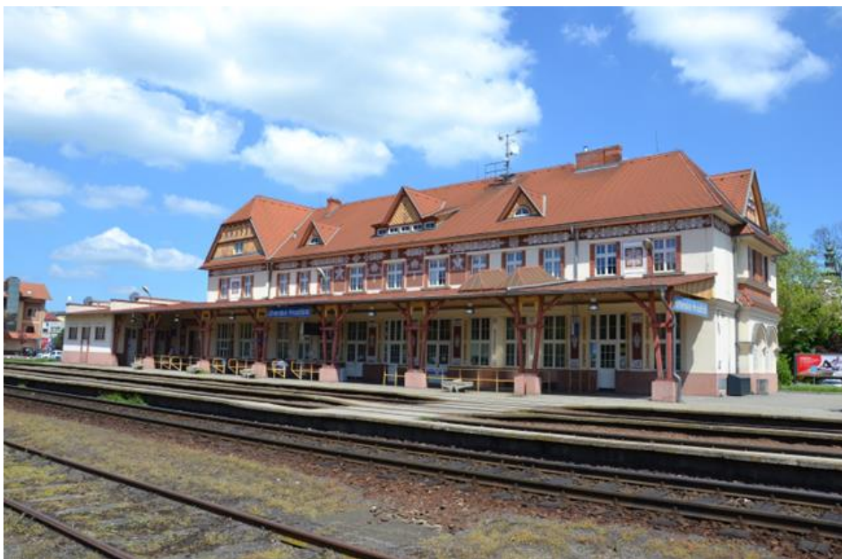
159. Uherské Hradiště, výpravní budova, pohled od nástupiště.
