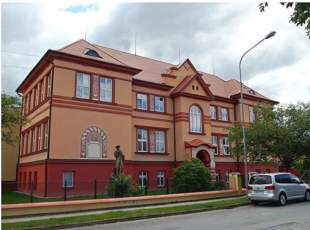
263. Strážnice, bývalá Zemská hospodářská škola, 1925, stavitel Josef Doležal, pohled od západu.
