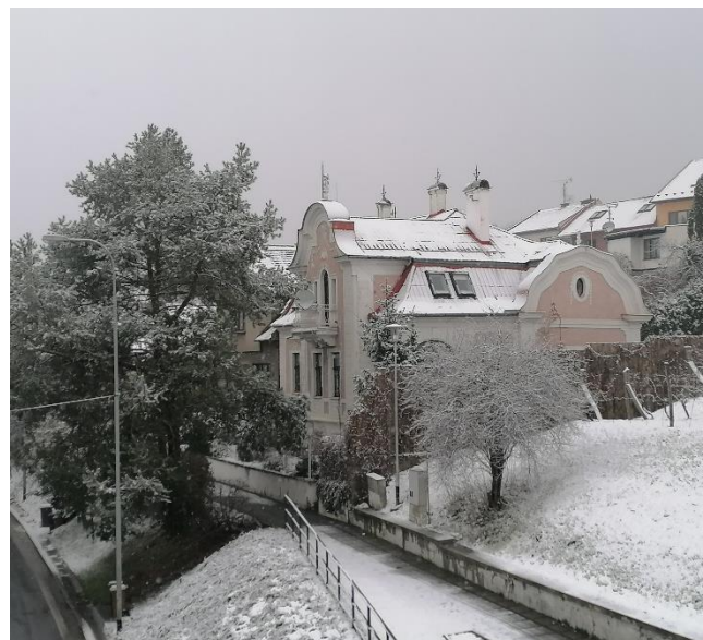
180. Uherský Brod, vila pro p. Menzla v ulici Pod Vály čp. 738 vně městských hradeb, 1911, stavitel Karel Málek z Uherského Brodu, pohled od východu.
