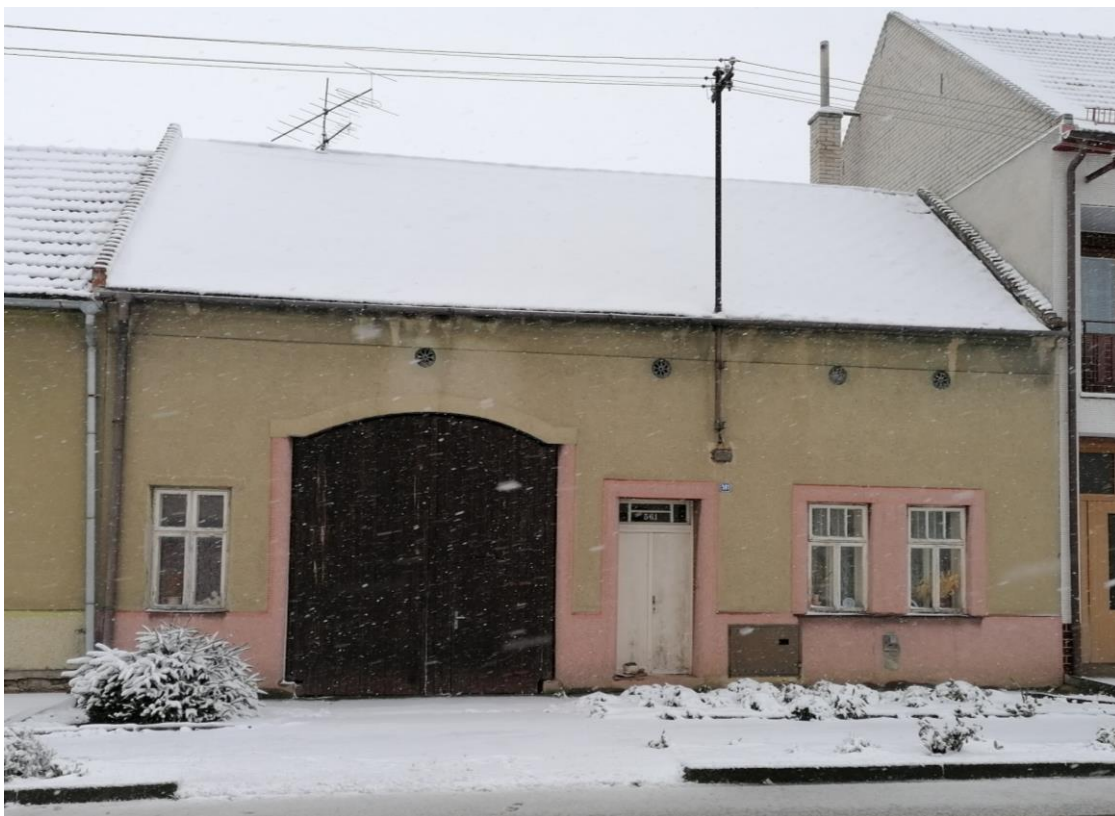
366. Blatnice pod Svatým Antonínkem, dům čp. 561, první polovina 20. století, pohled od východu.
