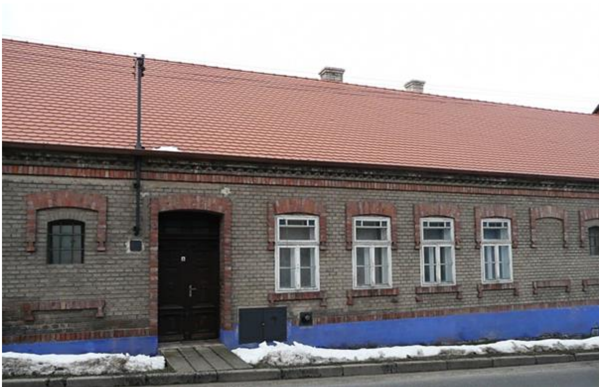
253. Vacenovice, dům čp. 100 v ulici Na Dědině s fasádou v režném zdivu s kombinovanou cihlovou výzdobou, první polovina 20. století, pohled od východu.
