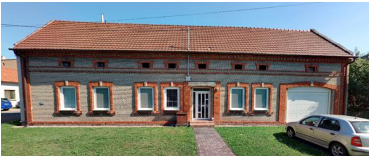
255. Traplice, dům čp. 74 z režného zdiva složeného z bílých a červených cihel s novodobými okenními a dveřními otvory, první polovina 20. století, pohled od západu.
