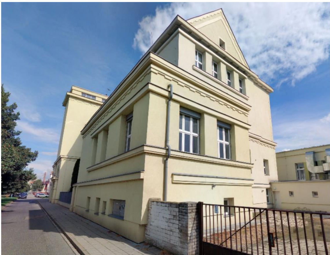
217. Břeclav, budova Obchodní akademie čp. 1224, 1924–1926, architekt Jaroslav Rössler, pohled od jihozápadu.
