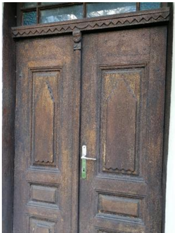
372. Blatnice pod Svatým Antonínkem, detail dveří domu čp. 568, první polovina 20. století.
