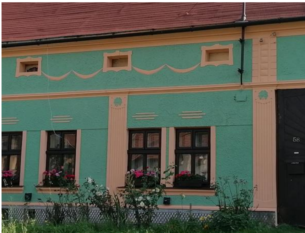
407. Vlčnov, detail výzdoby domu čp. 58 v ulici Tyršova, dvacátá až třicátá léta 20. století.
