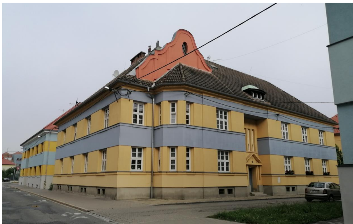
120. Uherské Hradiště, obytný dům typ VI.a v ulici Kollárova čp. 404, 1923–1927, pohled od východu.
