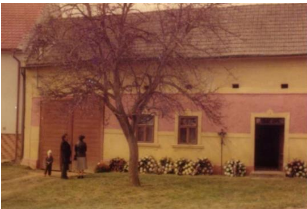
238. Kněžpole, dům čp. 24 s fasádní úpravou ze třicátých let 20. století (zbořen), pohled od východu.
