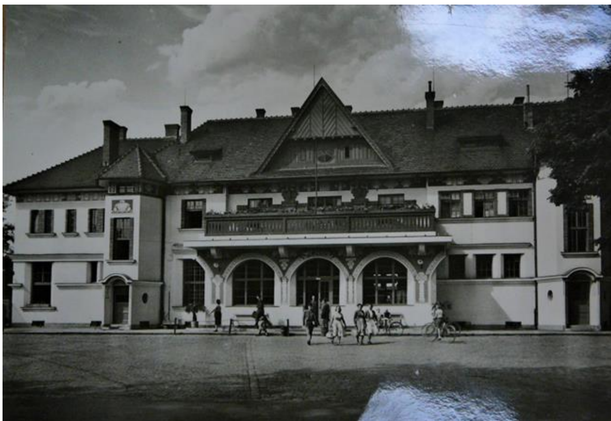
157. Uherské Hradiště, výpravní budova, před rokem 1957.
