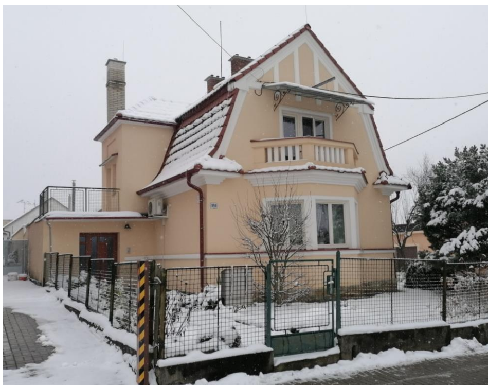
181. Uherský Brod, vila čp. 956 v ulici 28. října, první polovina 20. století, stavitel Karel Málek z Uherského Brodu, pohled od jihozápadu.
