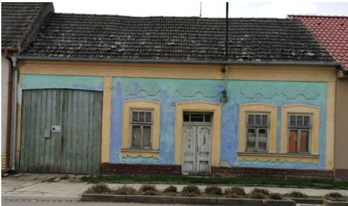
374. Blatnice pod Svatým Antonínkem, dům čp. 569, první polovina 20. století, pohled od východu.
