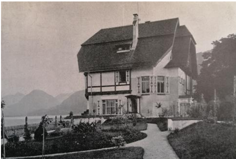
5. Sankt Gilgen (dnešní Rakousko), Vila Ferdinanda Tondera, 1905–1907, architekt Jan Kotěra.
