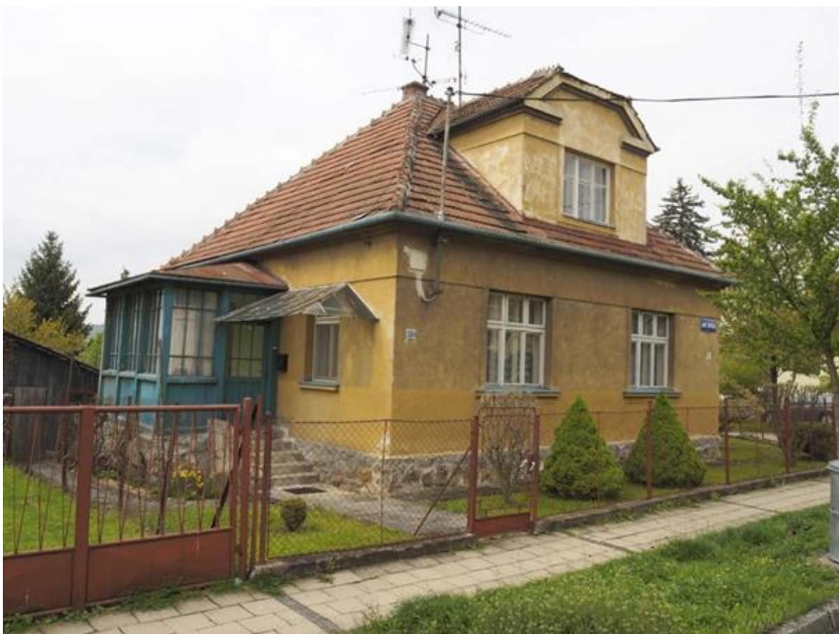
164. Uherský Brod, vilová stavba čp. 1164 v ulici Ant. Dvořáka, dvacátá až třicátá léta 20. století, pohled od východu.
