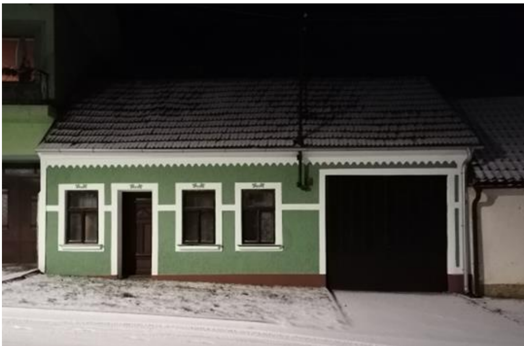
239. Korytná, dům čp. 95 s fasádní úpravou, první polovina 20. století, pohled od východu.
