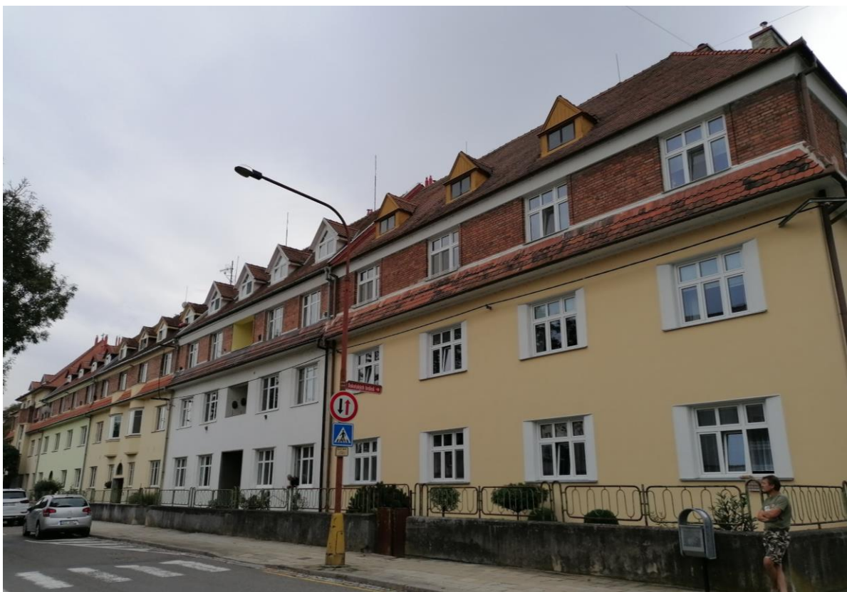
139. Uherské Hradiště, městské nouzové domy v ulici Štefánikova, 1925–1926, pohled od severu.
