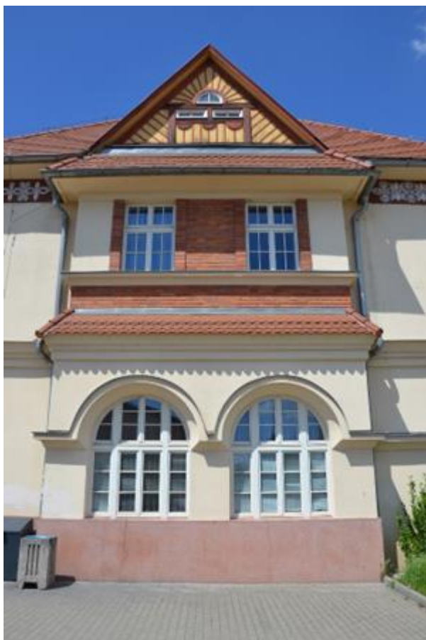
151. Uherské Hradiště, výpravní budova, pohled na boční rizalit.
