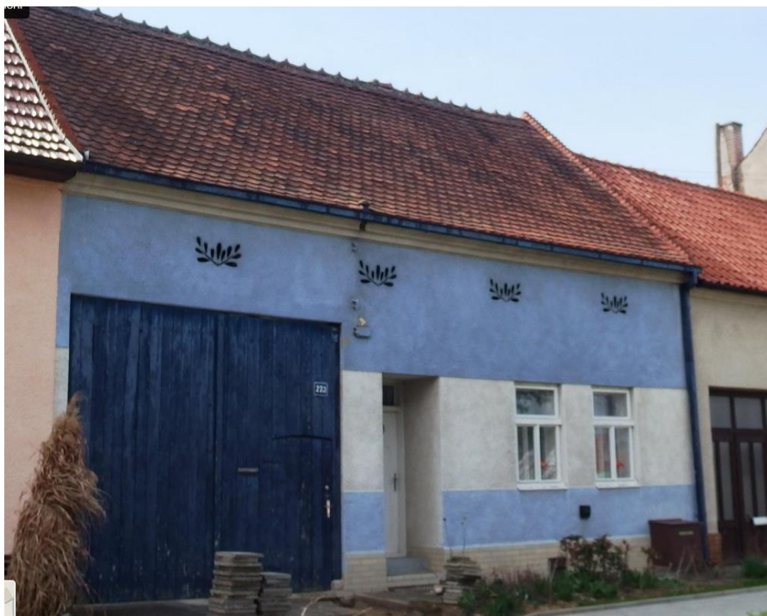
243. Horní Němčí, dům čp. 223 s větracími průduchy ve tvaru ratolesti, první polovina 20. století, pohled od severovýchodu.
