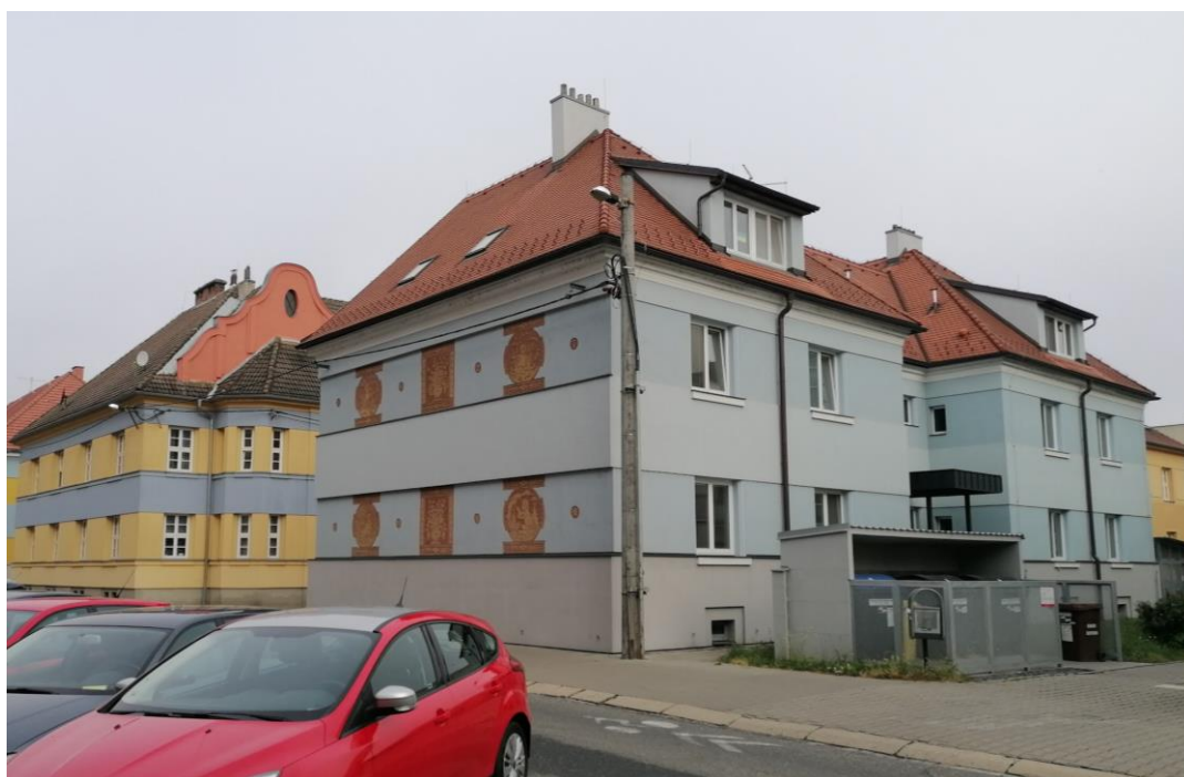
134. Uherské Hradiště, stavba obytného domu typ IX. v ulici Kollárova čp. 445, 1926–1927, pohled od jihovýchodu.
