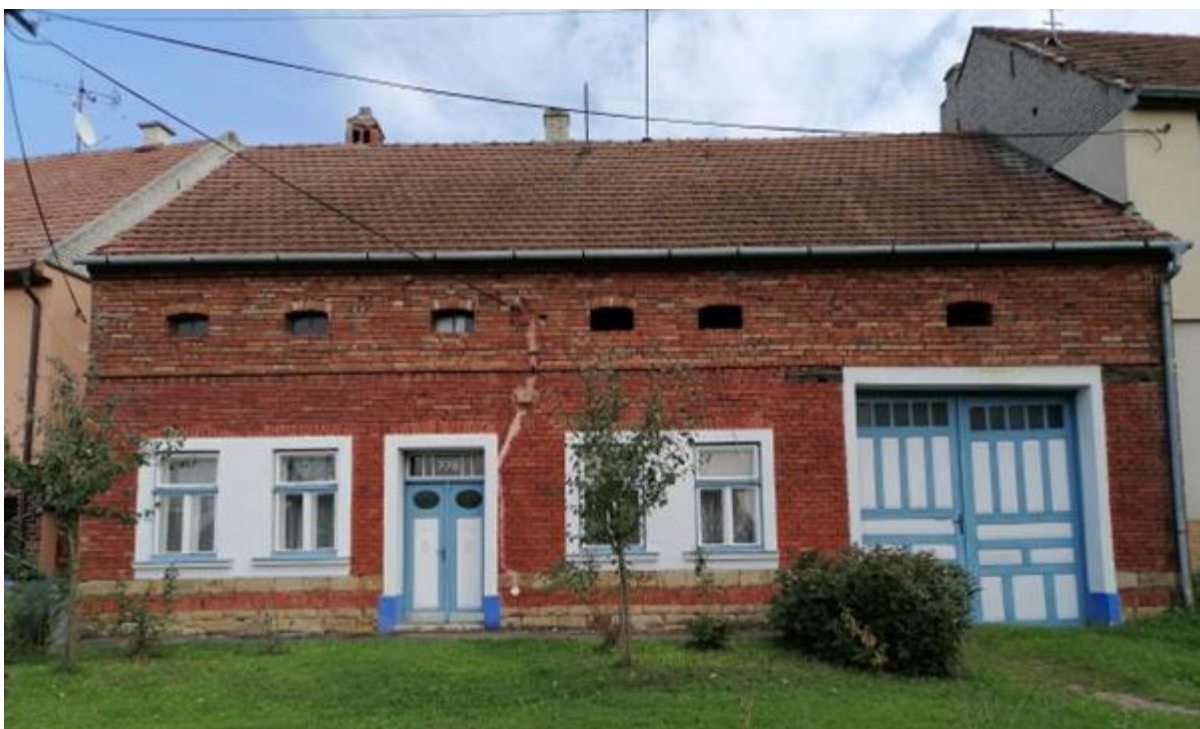
410. Vlčnov, dům čp. 776 v ulici Masarykova v režném zdivu s bílými šambránami, dvacátá až třicátá léta 20. století, pohled od západu.
