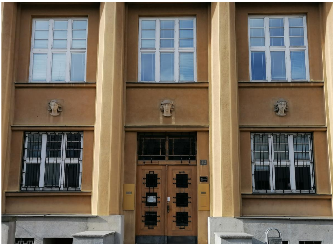
144. Uherské Hradiště, detail průčelí pobočky Národní banky na ulici Svatováclavská čp. 450, 1925–1926, architekt František Šnajdr, pohled od východu.
