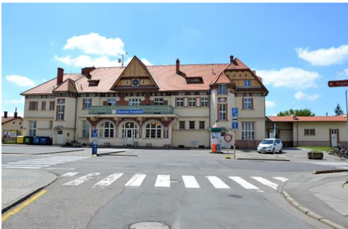
158. Uherské Hradiště, výpravní budova, stav 2019, pohled z přednádraží.
