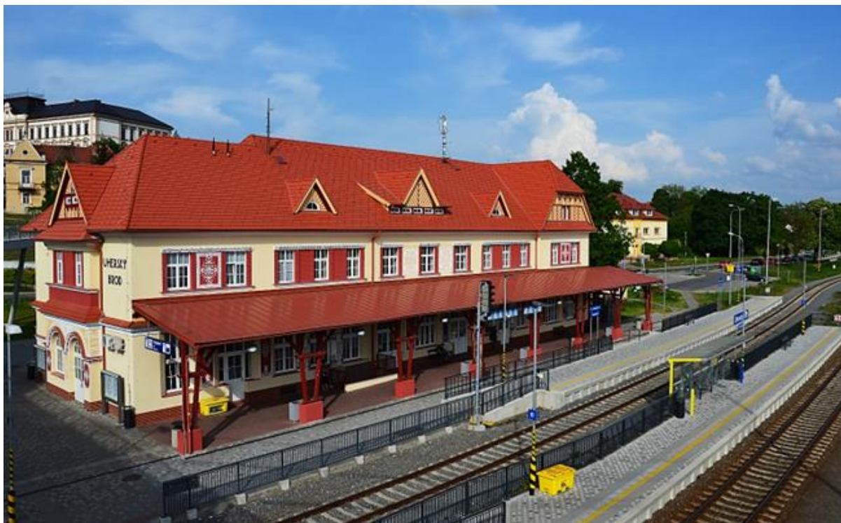
191. Uherský Brod, výpravní budova, západní pohled z lávky.
