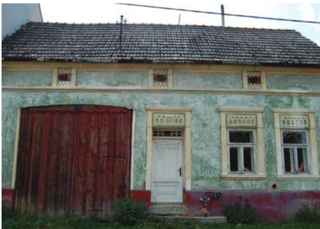
289. Slavkov, dům čp. 176 s bohatou štukovou výzdobou, první polovina 20. století, pohled od severovýchodu (přestavěn).
