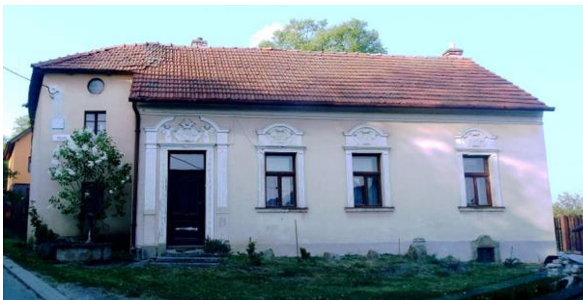
418. Bojkovice, dům se štukovou výzdobou čp. 90 v ulici Potok, první polovina 20. století, pohled od jihozápadu.
