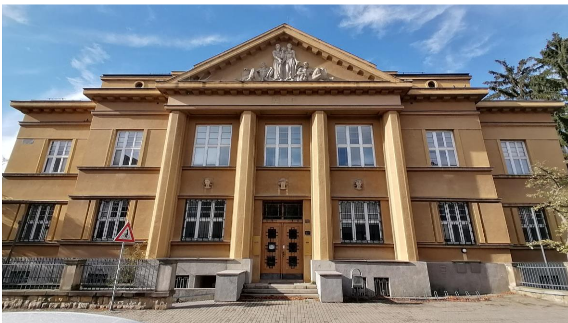
141. Uherské Hradiště, pobočka Národní banky na ulici Svatováclavská čp. 450, 1925–1926, architekt František Šnajdr, pohled od východu.
