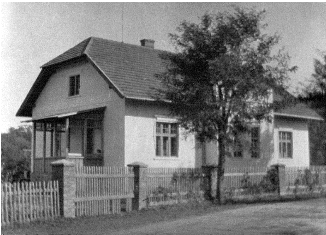
73. Veletiny, letní vila čp. 130 Lubora Niederleho zv. Morava, 1911, pohled od severozápadu.
