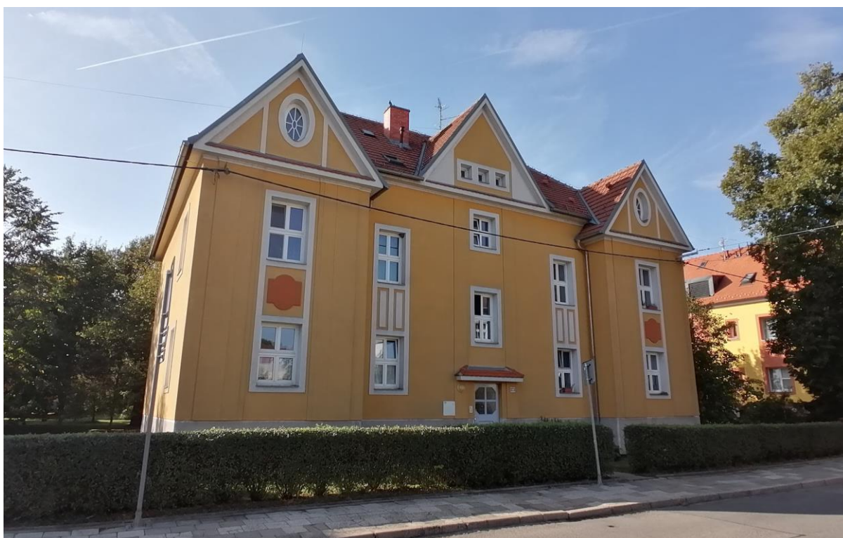
112. Uherské Hradiště, činžovní nouzový dům typu II. v ulici Jana Blahoslava čp. 373, pohled od východu.
