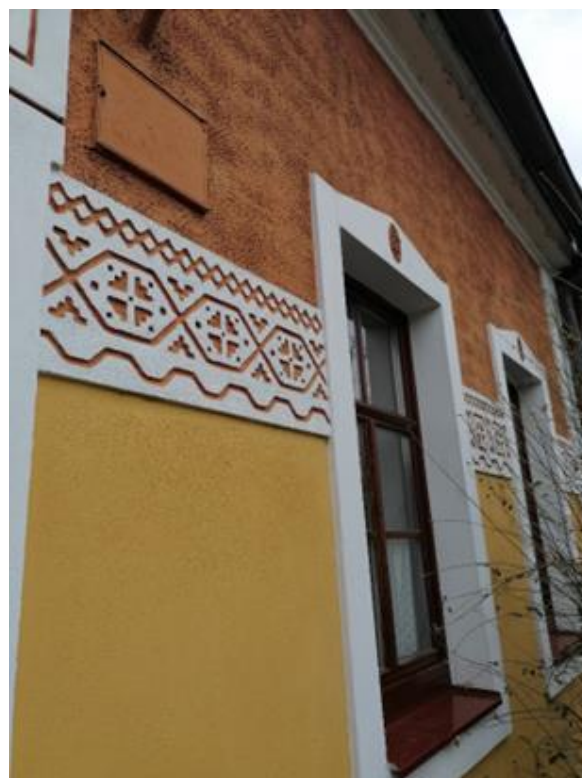
391. Kunovice, detaily domu čp. 274, kolem 1910–1915, pohled od západu.
