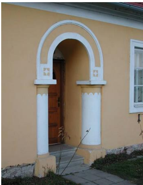
201. Uherský Brod – Havříce, detail žudra na domě ovlivněných secesním historismem - čp. 1005 na ulici Svatopluka Čecha, počátek 20. století, stavitel Cyril Kubíček (zbořeno).
