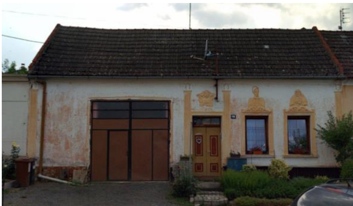
416. Uherské Hradiště-Míkovice, dům čp. 119 v ulici Radovy, první polovina 20. století, pohled od severovýchodu.
