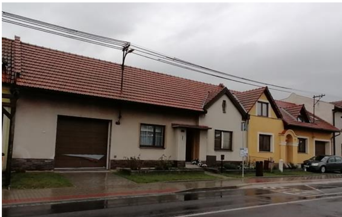
19. Uherské Hradiště – Sady, nové domy s žudry čp. 60 a 90 z protipovodňové akce postavené po roce 1920 a dokončené v roce 1925, pohled od západu.
