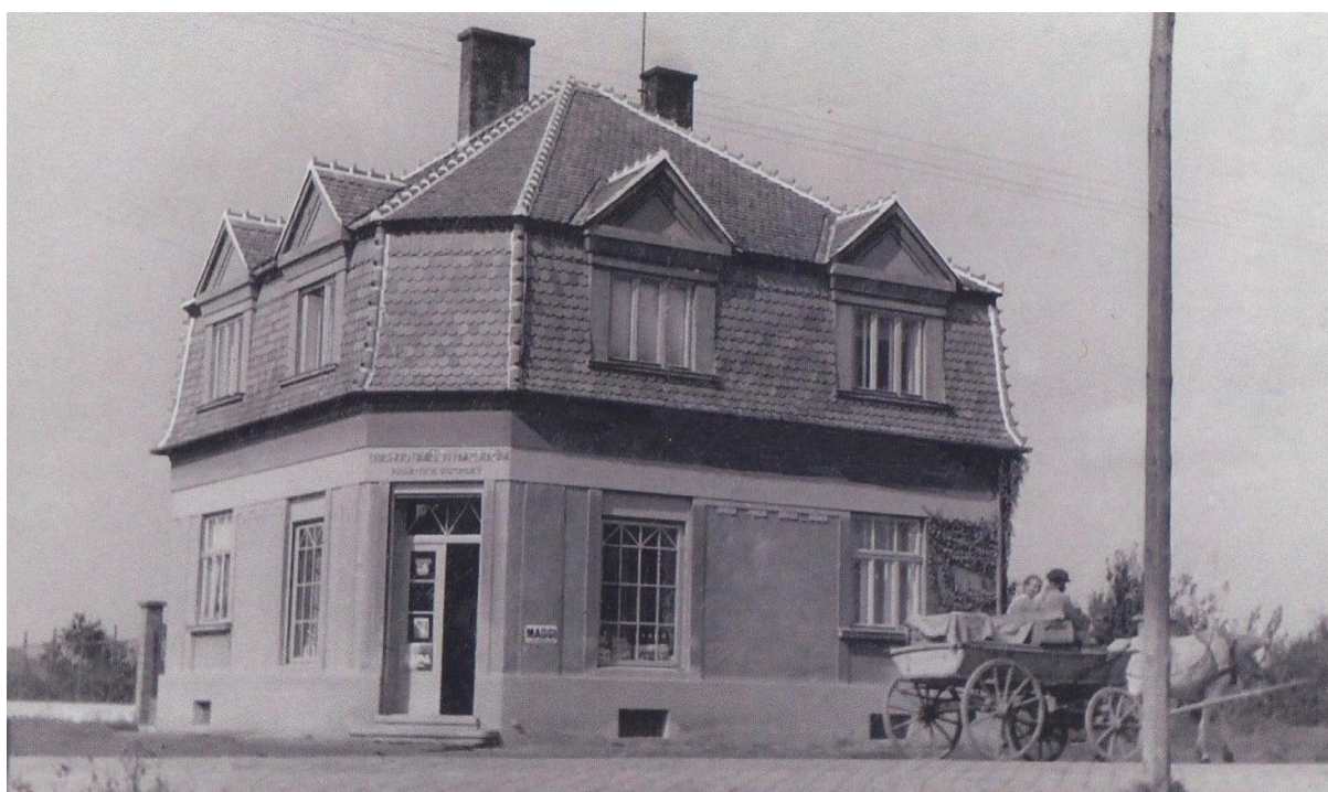
214. Břeclav, dům čp. 1275/2 na rohu ulic Herbenova a Lidická, 1920, stavitel Karel Hvězda, pohled od východu.
