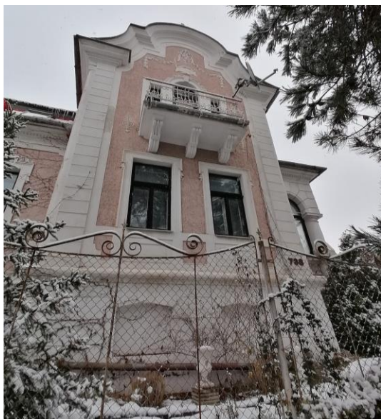
179. Uherský Brod, vila pro p. Menzla v ulici Pod Vály čp. 738 vně městských hradeb, 1911, stavitel Karel Málek z Uherského Brodu, pohled od jihozápadu.
