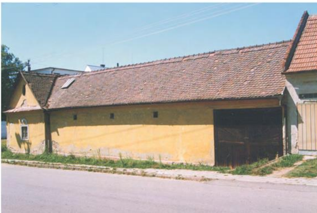
197. Uherský Brod – Havřice, domy ovlivněné secesním historismem - čp. 1005 na ulici Svatopluka Čecha, počátek 20. století, stavitel Cyril Kubíček (zbořeno).
