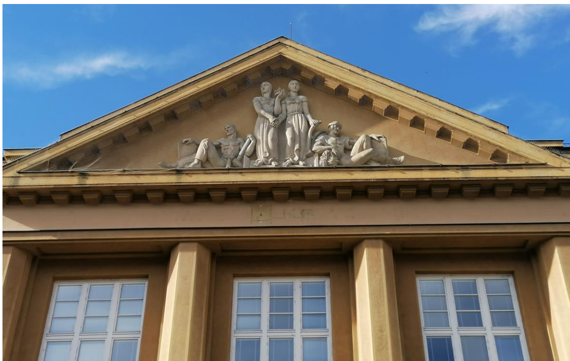
143. Uherské Hradiště, detail průčelí pobočky Národní banky na ulici Svatováclavská čp. 450, 1925–1926, architekt František Šnajdr, pohled od východu.
