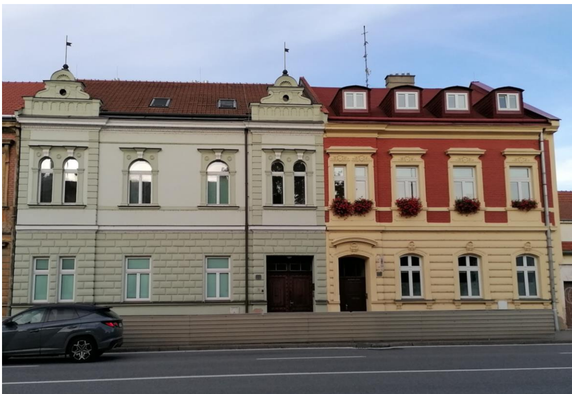
57. Uherské Hradiště, jednopatrové domy čp. 246 a 247 na Velehradské ulici 1896–1897, stavitel Josef Schaniak, pohled od jihu.
