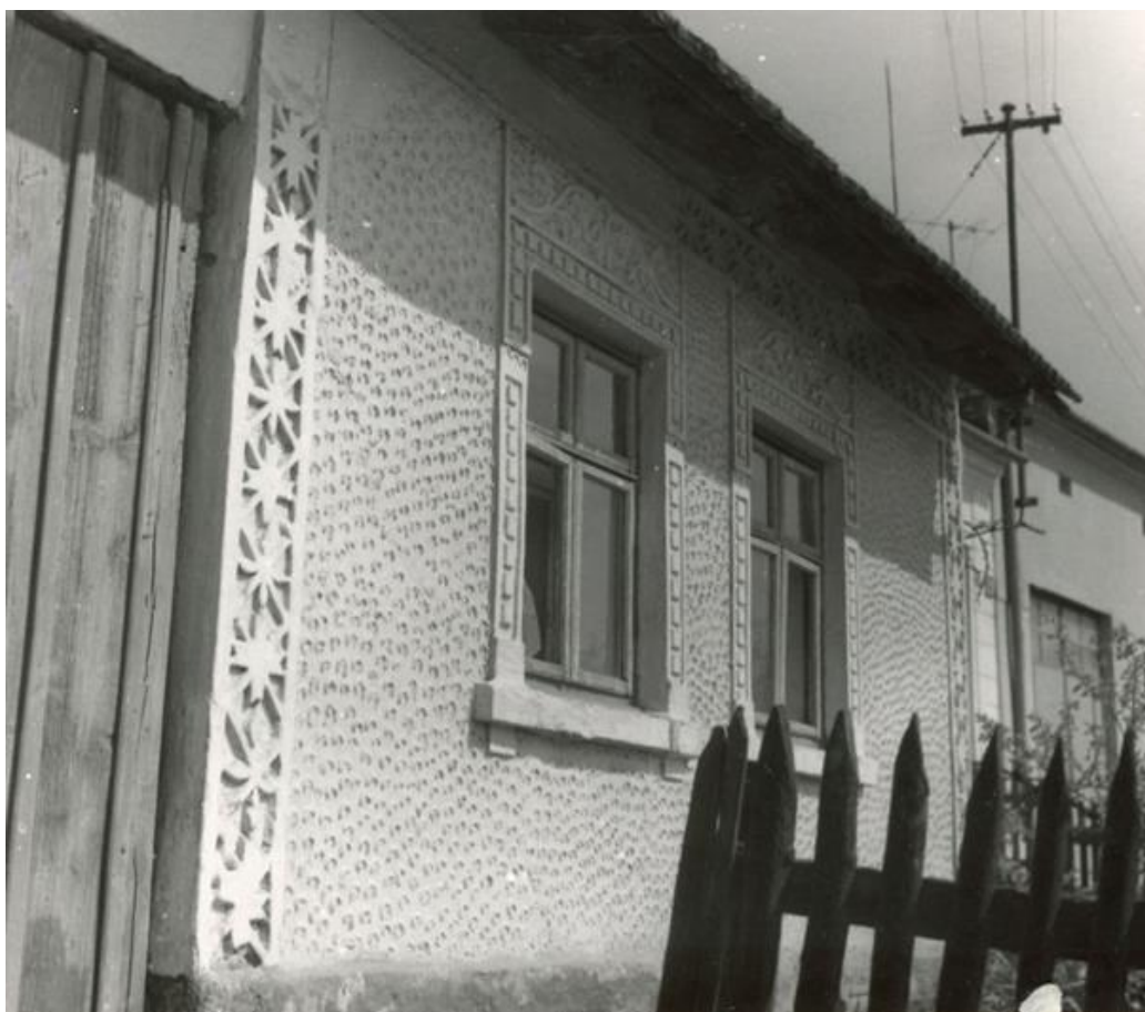
287. Popovice, nedochovaný dům čp. 31 s bohatě zdobenou, geometrizovanou štukovou fasádou v partiích oken, nároží a korunní římsy, první polovina 20. století, pohled od jihozápadu.
