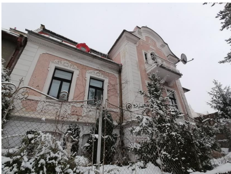
178. Uherský Brod, vila pro p. Menzla v ulici Pod Valy čp. 738 vně městských hradeb, 1911, stavitel Karel Málek z Uherského Brodu, pohled od jihozápadu.
