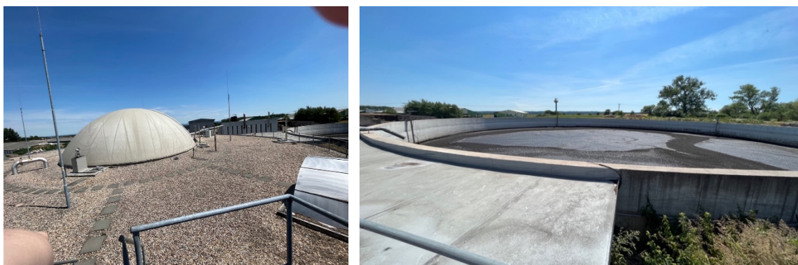
Obrázek 6: Zleva: Bioplynový reaktor v zemědělském družstvu Červené Janovice, Fermentační zbytek uskladněn v železobetonové nezastropené jámě, (Vondrášková 2022)
