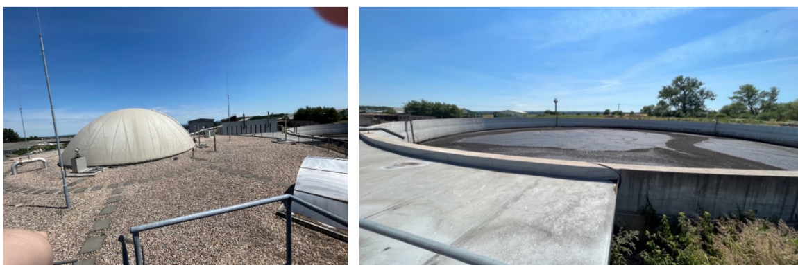
Obrázek 6: Zleva: Bioplynový reaktor v zemědělském družstvu Červené Janovice, Fermentační zbytek uskladněn v železobetonové nezastropené jámce, (Vondrášková 2022)
