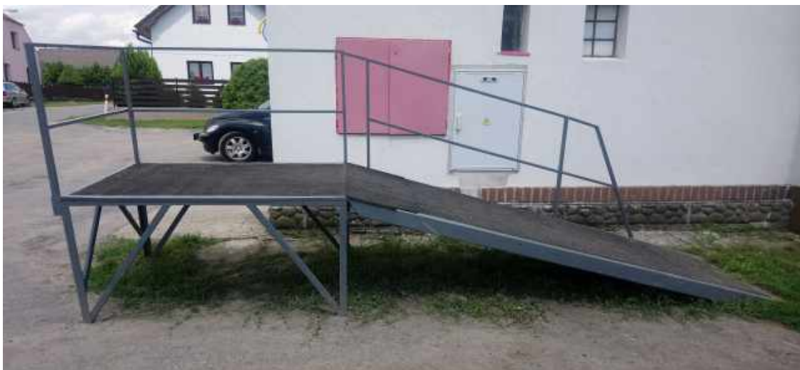
Obrázek 11: Rampa s nájezdovou plošinou; Lenka Černá 2020
