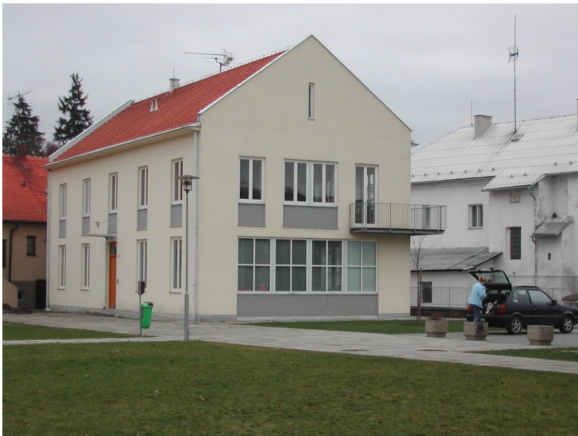
Příloha č. 7 Budova školní družiny
