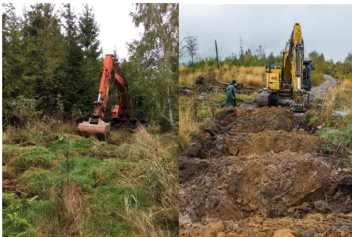
Obrázek č. 14: Varianta kypření (vlevo) versus varianta jáma-hráz-jáma (vpravo) s realizací na dvou různých místech ve dvou odlišných podmínkách. Zdroj: Archiv autora, 2022 (vlevo); Voda pro les, voda pro lidi, 2020 (vpravo)
