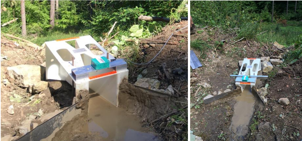
Obrázek č. 2: Parshallův žlab v průběhu instalace. Zdroj: Archiv autorky, 2022
