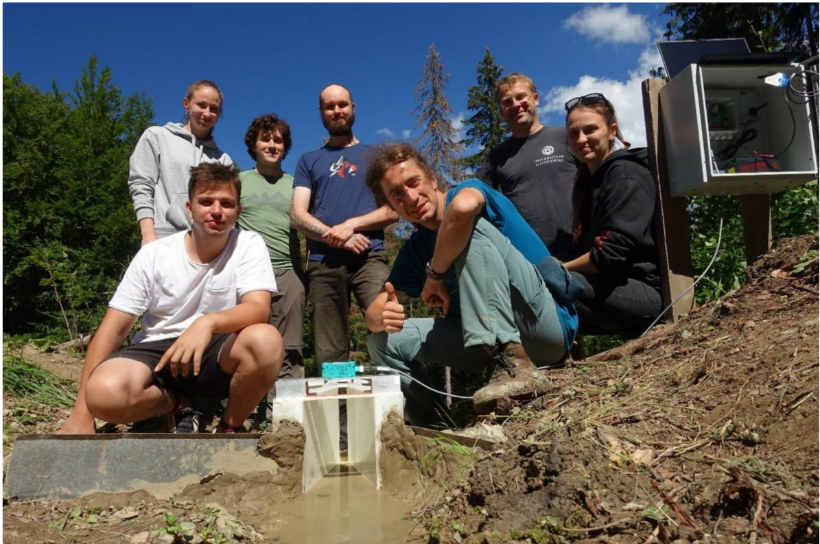
Obrázek č. 3: Parshallův žlab včetně přidružené pamětní schránky, kompletně uvedený do chodu. Zdroj: Mgr. Jan Husák, 2022
