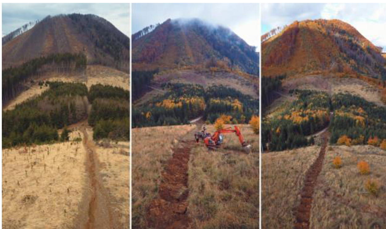
Obrázek č. 13: Metoda rozrušování utužených nepoužívaných přibližovacích linek a vytváření vhodného prostředí pro zasakování dopadené dešťové vody. Zdroj: Kvapka Rajeckej doliny n.o, 2023
