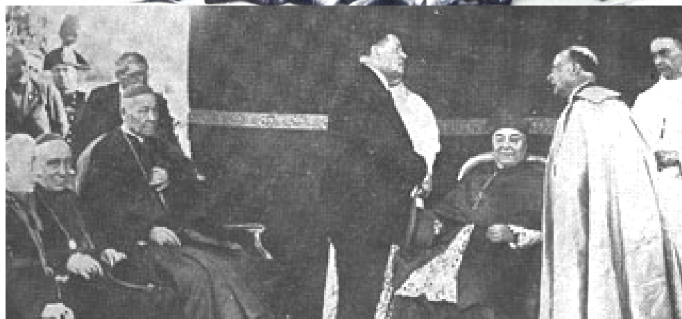
Položení základního kamene Nepomucena r. 1927. JUDr. Dostál jedná s kardinálem Pietrem Gasparrim a nunciem v ČSR F. Marmaggim.
