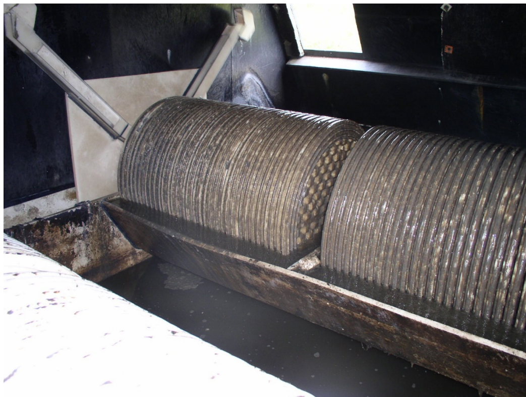
Obr. 15 Biodiskový reaktor
