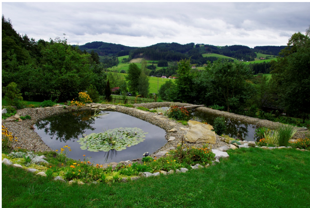
Obr. 12 Dočišťovací biologický rybník
