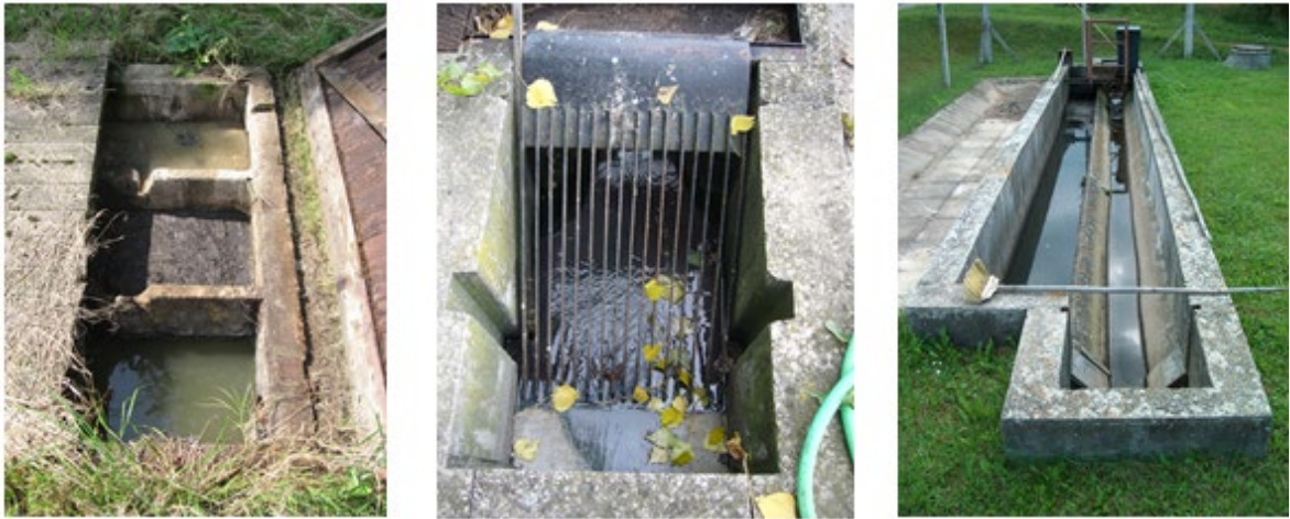
Obr. 8 z leva lapák tuku, uprostřed česle, zprava lapák písku
