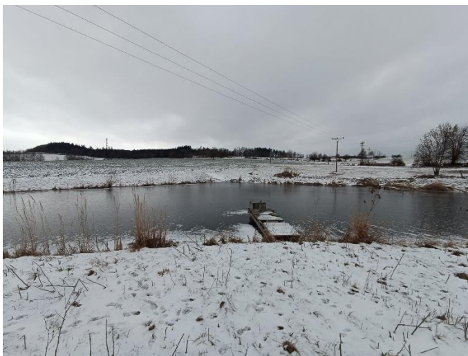
Obrázek 164 – nádrž na prameništi v úseku 51 (zdroj: vlastní zpracování)
