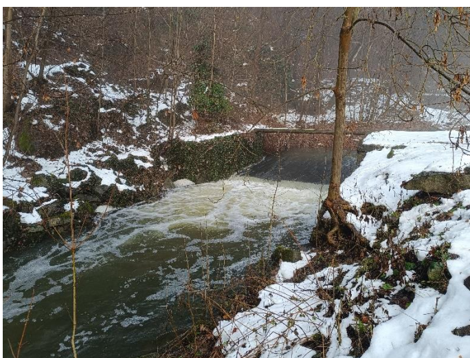
Obrázek 27 -vodní stupeň s vývřištěm v úseku 9 (zdroj: vlastní zpracování)
