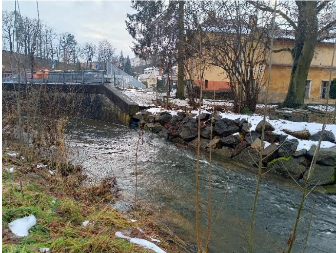
Obrázek 42 – opevnění břehu v úseku 14 (zdroj: vlastní zpracování)
