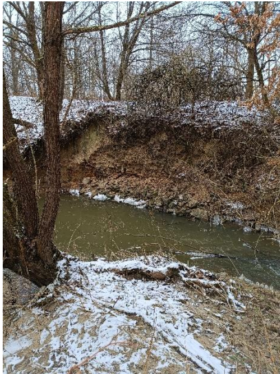
Obrázek 75 – břehová eroze v úseku 24 (zdroj: vlastní zpracování)
