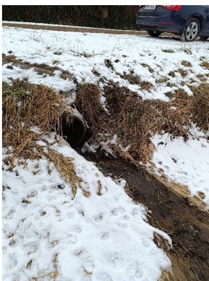
Obrázek 157 – vyústění zatrubněného toku (zdroj: vlastní zpracování)
