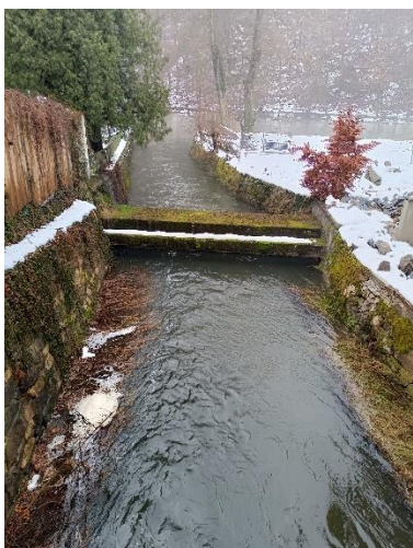
Obrázek 2 - úsek 1 po proudu (zdroj: vlastní zpracování)
