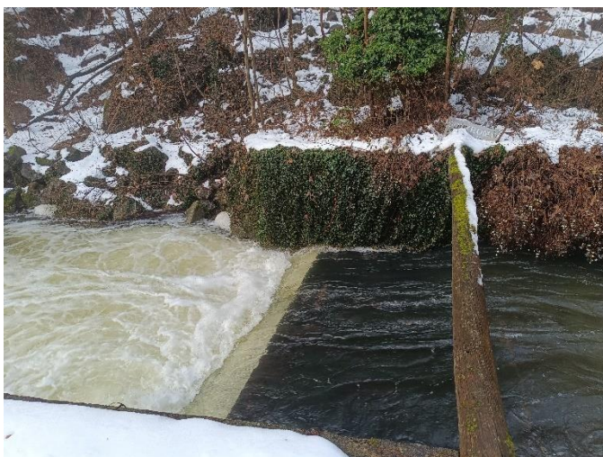
Obrázek 26 – vodní stupeň s vývřištěm v úseku 9 (zdroj: vlastní zpracování)
