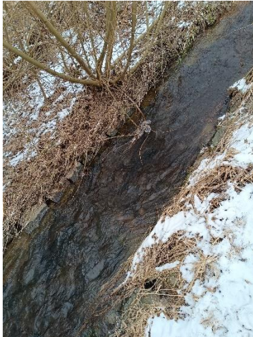
Obrázek 103 – zbylé opevnění v úseku 33 (zdroj: vlastní zpracování)
