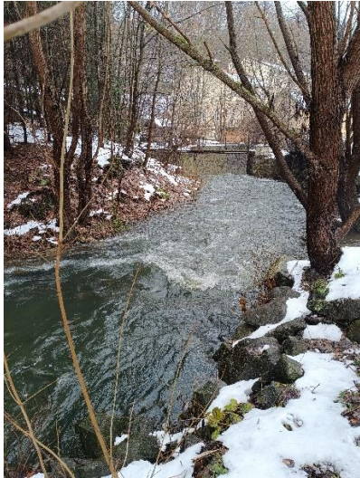
Obrázek 36 – úsek 12 po proudu před stupněm (zdroj: vlastní zpracování)
