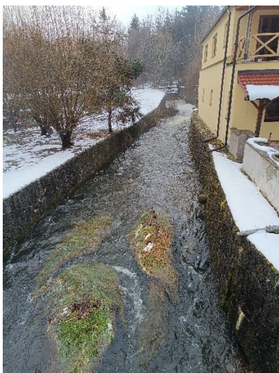
Obrázek 33 – zkapacitněné koryto v úseku 11 (zdroj: vlastní zpracování)
