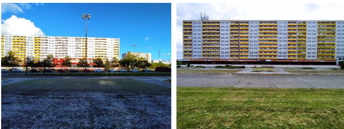
13. Podium - pohled z parteru do třídy a ze středu komunikace na parter. Zdroj: archiv autora
